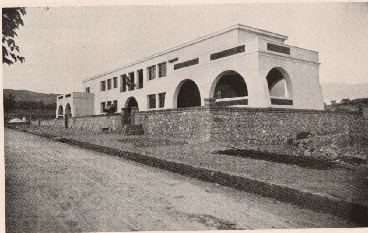
Vista general del edificio.
