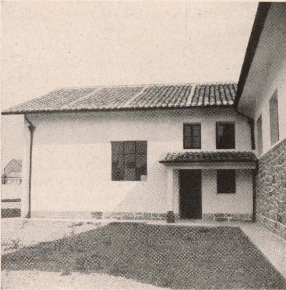
Aspectos parciales del nuevo Matadero de Guernica.
