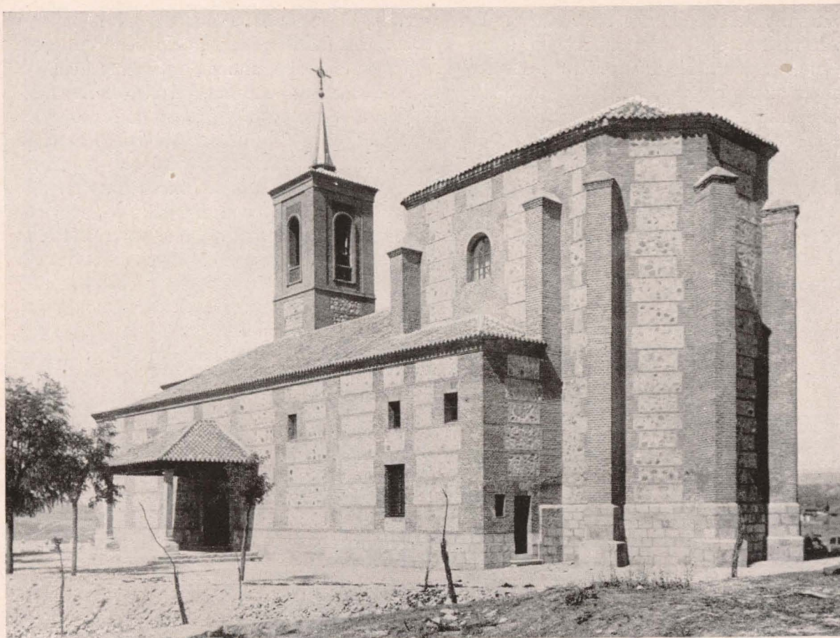
El templo, totalmente reconstruido.
