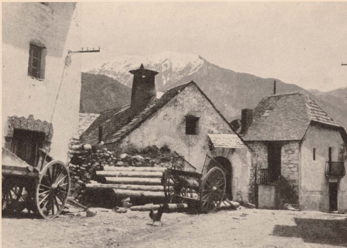
Bielsa antes de la destrucción.
