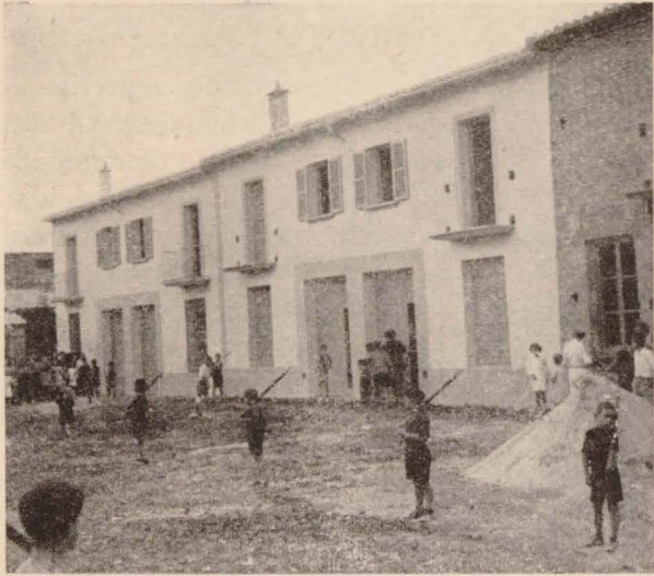
Nules: Nuevas viviendas. Exterior.
