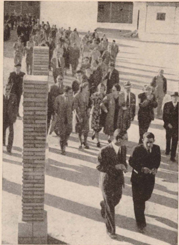
Belchite: El Director general de Regiones Devastadas y los técnicos de la reconstrucción nacional visitan las obras.
