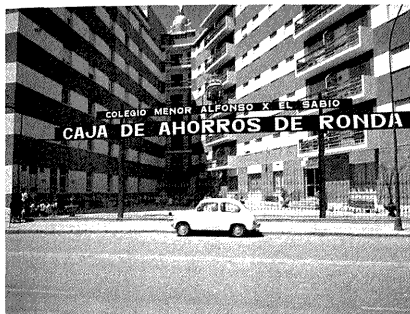
3 Edificio del Colegio Menor Alfonso X El Sabio, Ciudad Real, hacia 1974. El edificio ha sido derruido en el verano de 2006.
