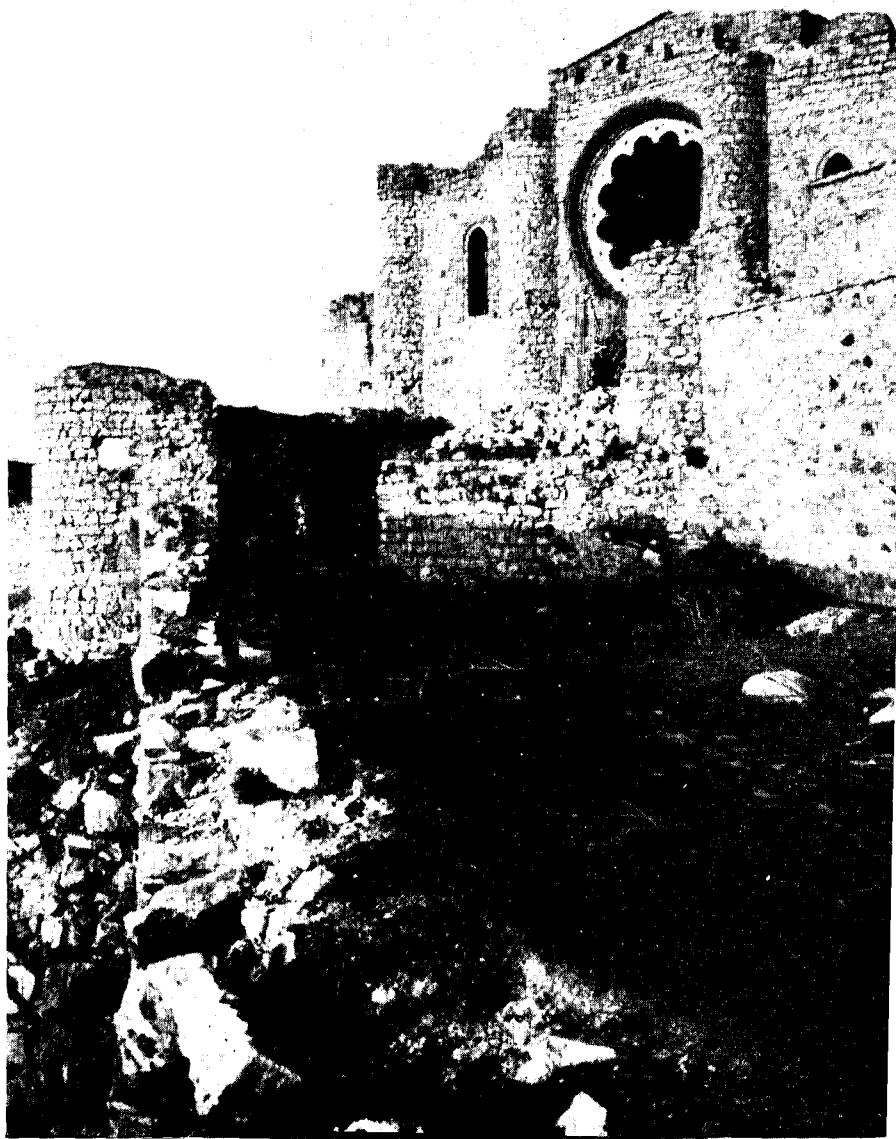
10.— Calatrava la Nueva. Pasillo de entrada a la Iglesia desde el Castillo. A la derecha se observa el muro de Poniente del Campo de los Mártires, uno de cuyos cubos tapa parcialmente la puerta del templo.
