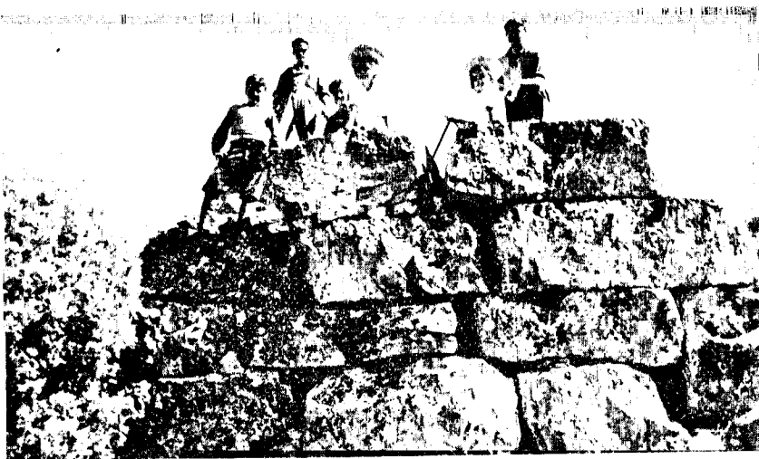
"Sala de los Moros" Angulo Oeste-Norte del muro exterior.
