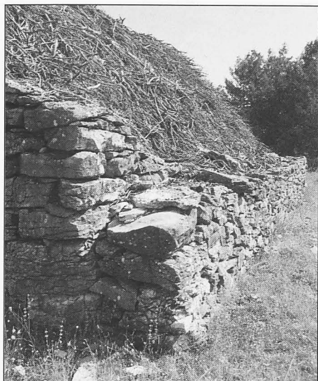
Contramuro del muro perimetral.
