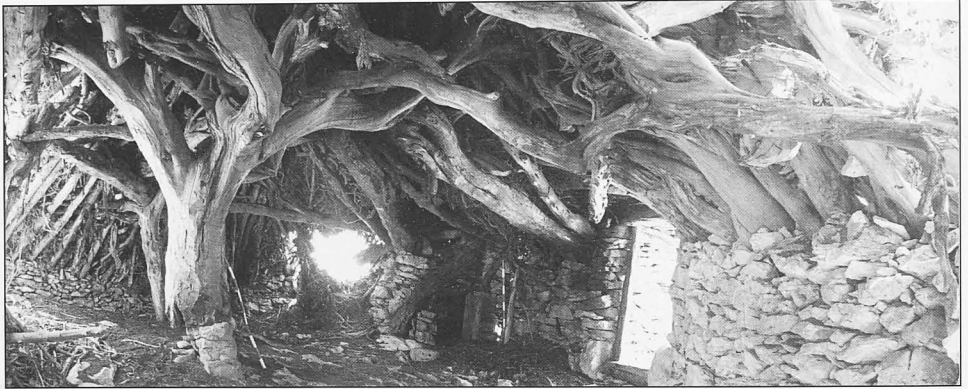
Pilar central o sabinorro en posición de vida, “descalzado”. Villar de Cobeta.
