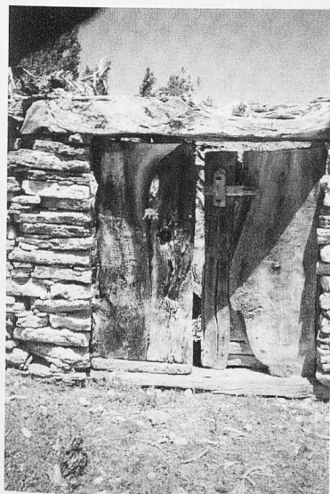
Puerta de un chozón con su tarabilla Mochales
