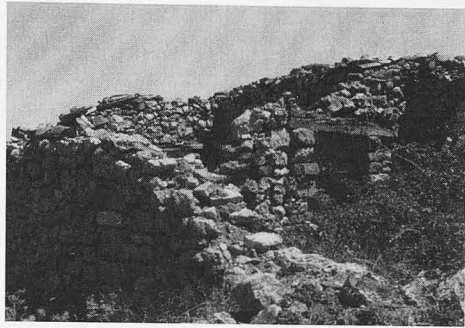
Foto 5. Campillo de Dueñas: Restos del almacén
