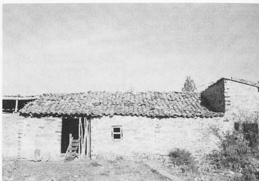
Foto 35. Torrecuadradilla: Nave del tejar nuevo
