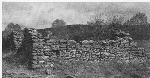
Foto 30. Tamajón: Restos del obrador-almacén
