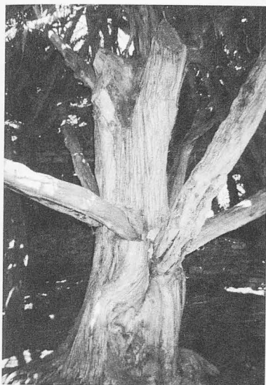
Sabina central de un chozón con cabrios de sabina a modo de tirantes Amayas
