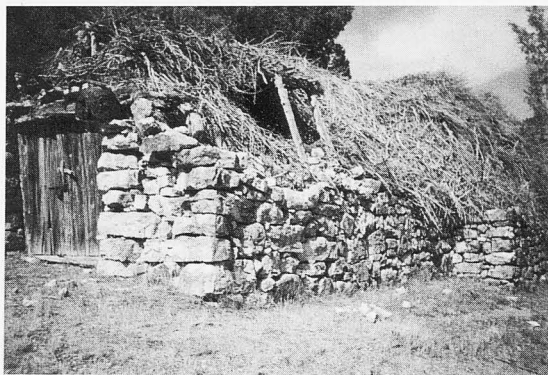
Chozón con ventana o tronera en el tejado, en la puerta se observa la tranca o tarabilla y el oxidado candado Ablanque
