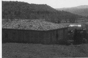
Foto 12. Henche: Tejado de la Casa Grande
