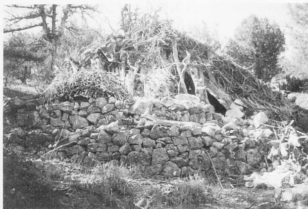
Chozón con doble pared Ablanque
