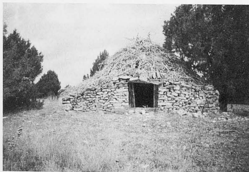
Detalle de la puerta del chozón con losas de piedra a modo de alero Lebrancón
