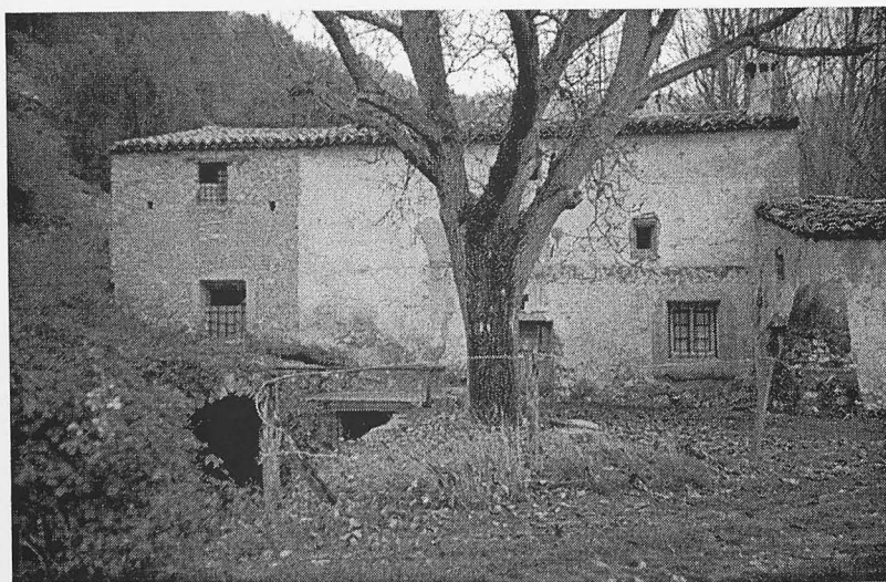
Foto 29 CUEVAS LABRADAS. MOLINO DE CUEVAS LABRADAS Amplio edificio perfectamente conservado, con dos alturas y cubierta a dos aguas.
