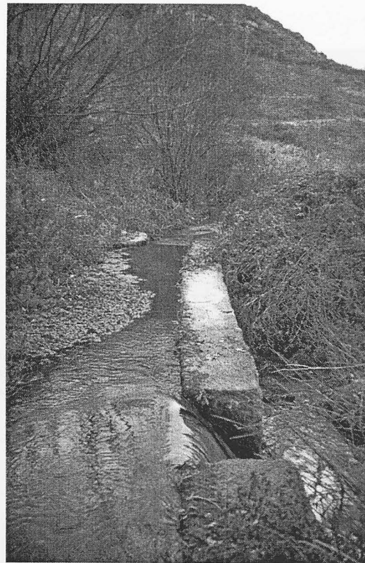
Foto 19 VALDEAVELLANO. MOLINO DEL TIO PATRICIO Y FABRICA DE LUZ El agua la proporciona un caz de más de mil metros de longitud...
