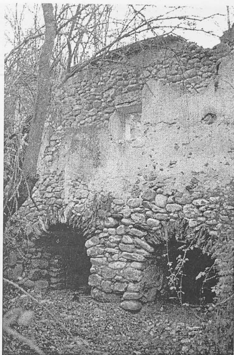
Foto 3 PUEBLA DE VALLES. MOLINO DE VICENTE El edificio es de canto rodado y adobe, todo ello enlucido.
