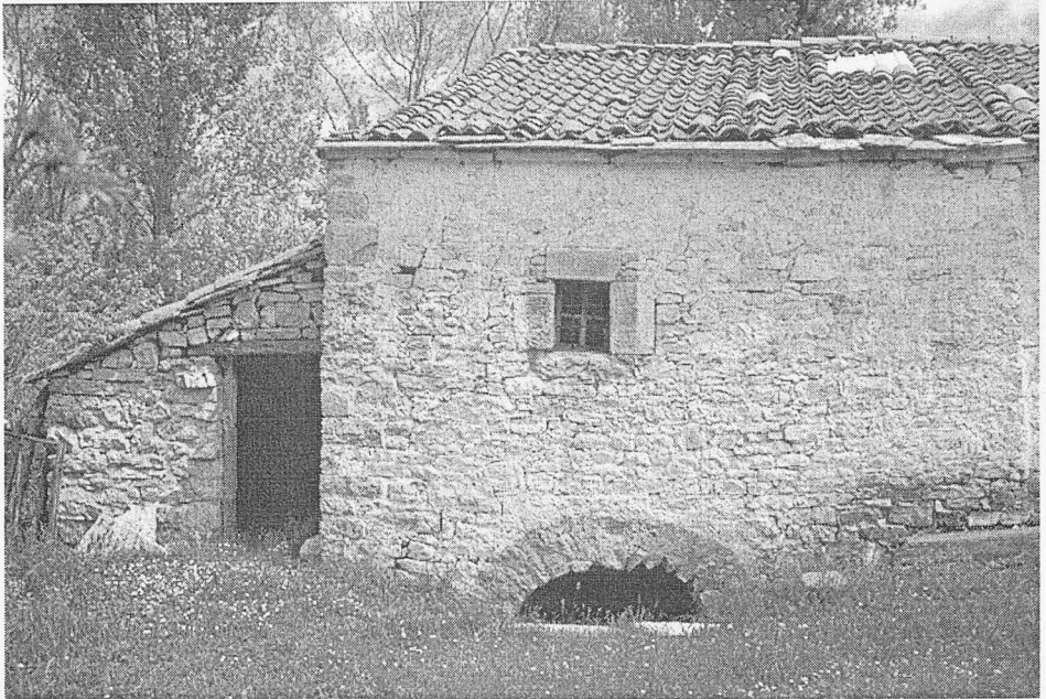
Foto 5 GALVE DE SORBE. MOLINO VIEJO DE LA VILLA ...es un edificio grande de sillarejo de piedra, con un pequeño anejo como cuadra adosado...
