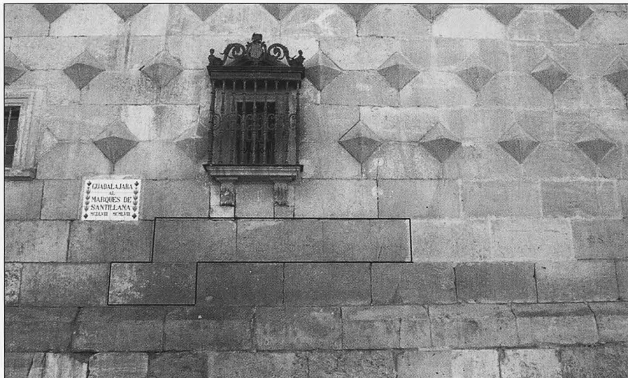
Lám. I: Situación de los graffiti en la fachada principal del Palacio del Infantado.
