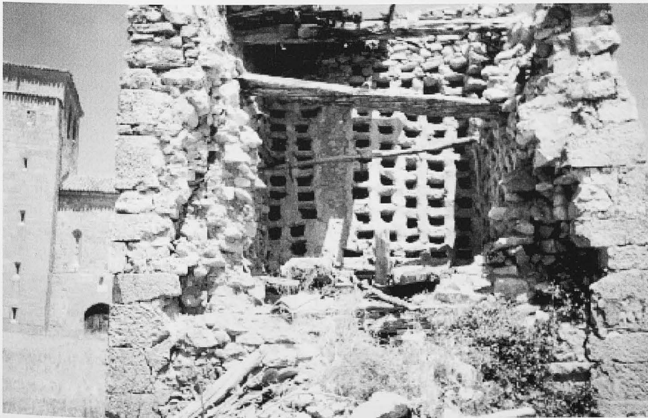
Palomar hundido en Concha Detalle de los nidales construidos con barro
