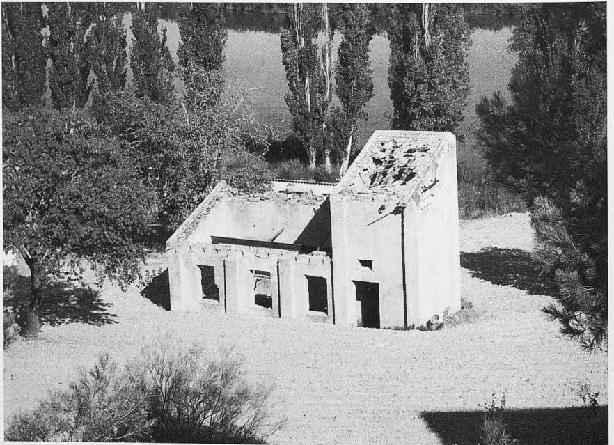
Casa bombeo de la comunidad de regantes de Cabanillas, construida en 1948
