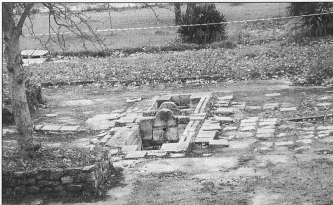
Foto 5.- Balneario de Trillo en reconstrucción.
