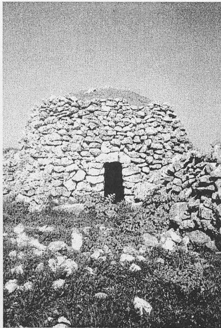
Fig. 17. bis, a. Cabaña en la carretera Fuentelencina-Pastrana.
