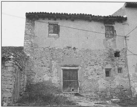
Corduente. Vivienda del caserío de Santiuste. Su alero es de troncos y tablazón de madera.
