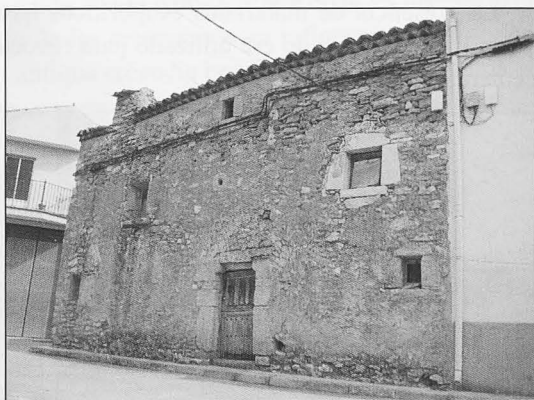
Anchuela del Campo. Tipología de vivienda humilde: escasa de vanos con lucernario y chimenea adosada al muro.
