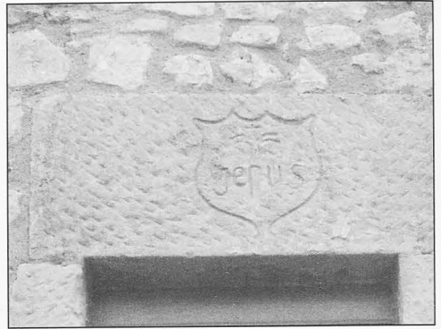
Mazarete. Dintel de una ventana.
