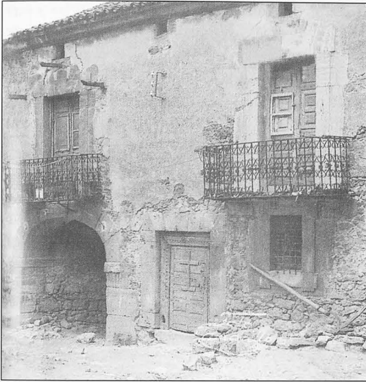
Cruz de madera tallada en al puerta de una vivienda de la plaza nueva de Zaorejas. (Legado Camarillo).
