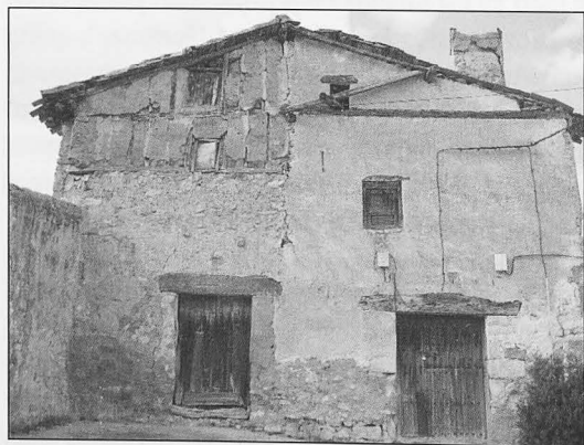
Terzaga. Vivienda con entramados de madera.
