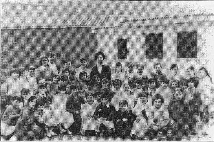
Niñas en las escuelas recién construida, año 1960.
