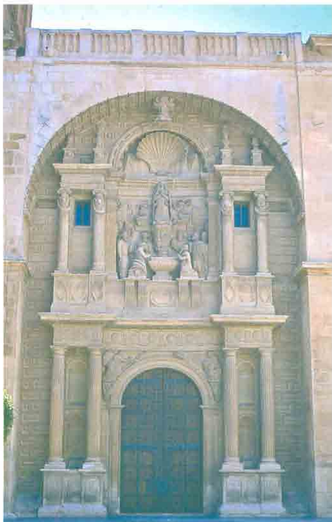
4. Portada-retablo de la Asunción (Almansa), con tres calles, dos pisos y ático. Remata el conjunto una balaustrada ciega.
