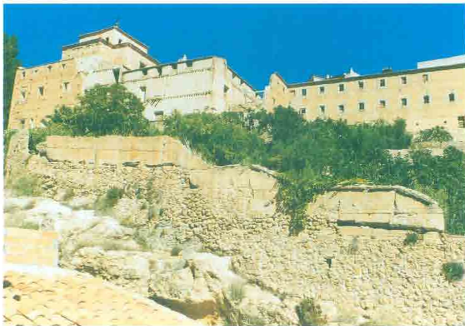
Fot. 3. Exconvento carmelita, Vista actual de su aspecto exterior, Liétor.
