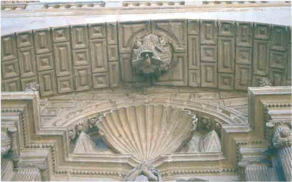
10. Detalle del arco acasetonado que cubre la portada, con la "clave pinjante" en la que aparece la paloma del Espíritu Santo.
