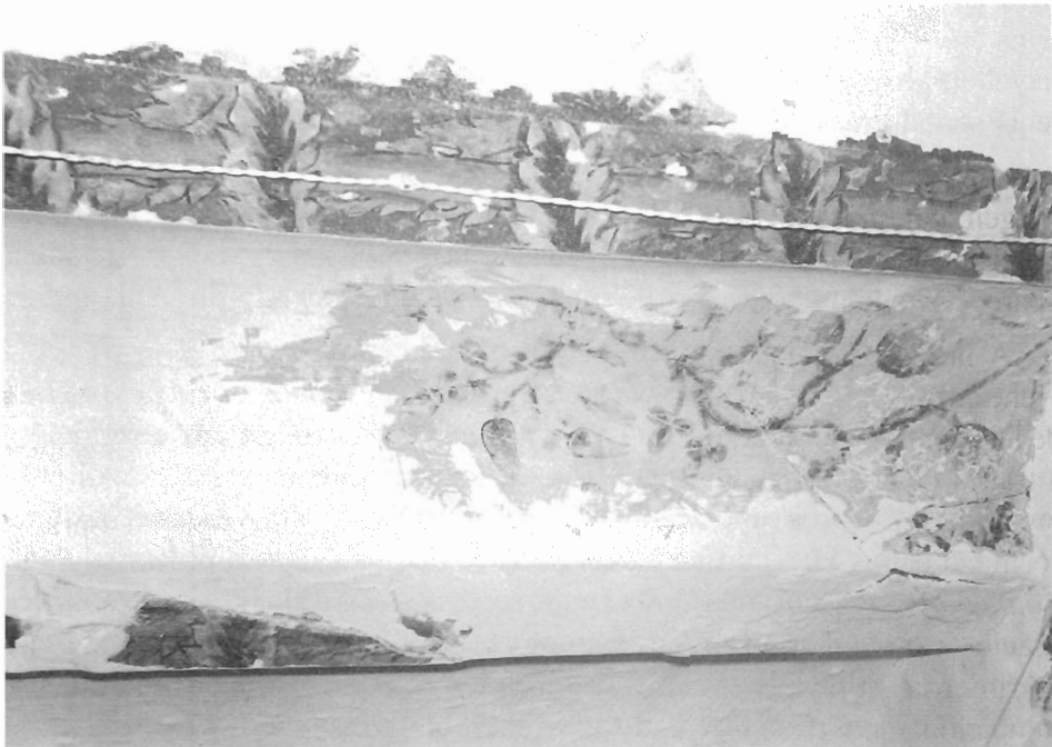
Fot. 5 - Restos de la decoración de las vigas y de los revoltones de una de las salas.
