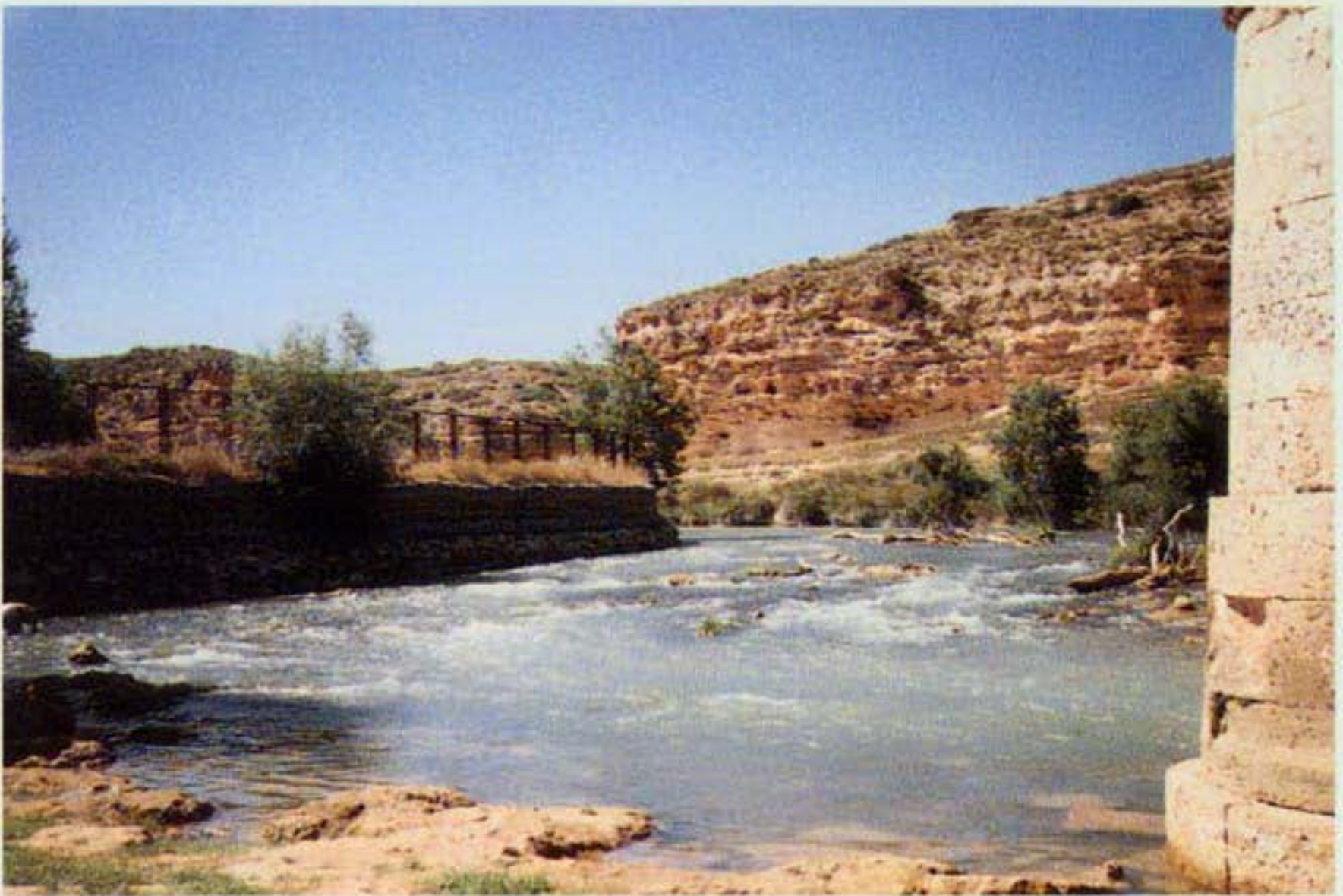
Estación J-4: Puente carretera de Motilleja.
