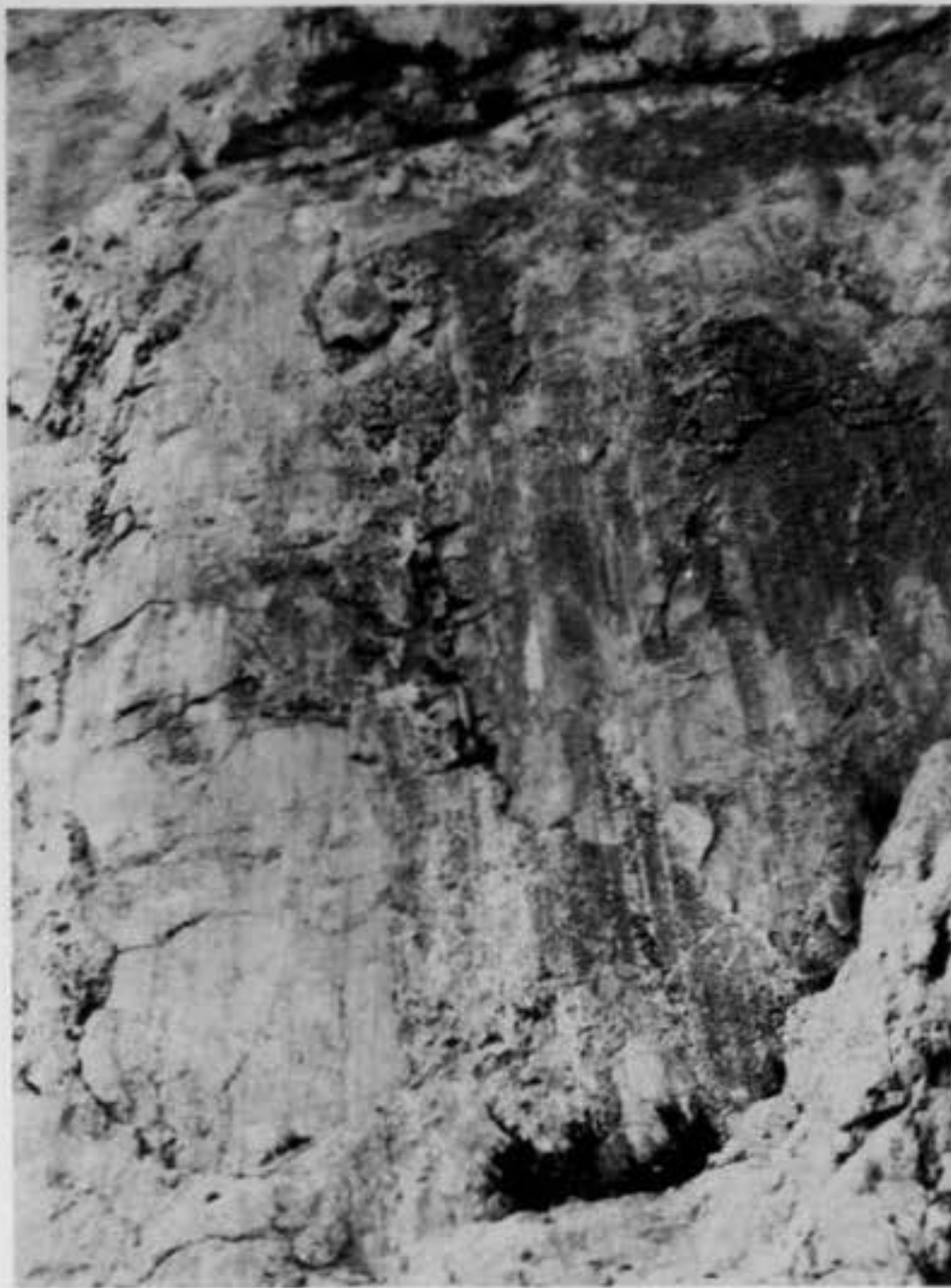
Fotog. n.º 20: Carretera Albacete-Murcia: Espejo de falla.
