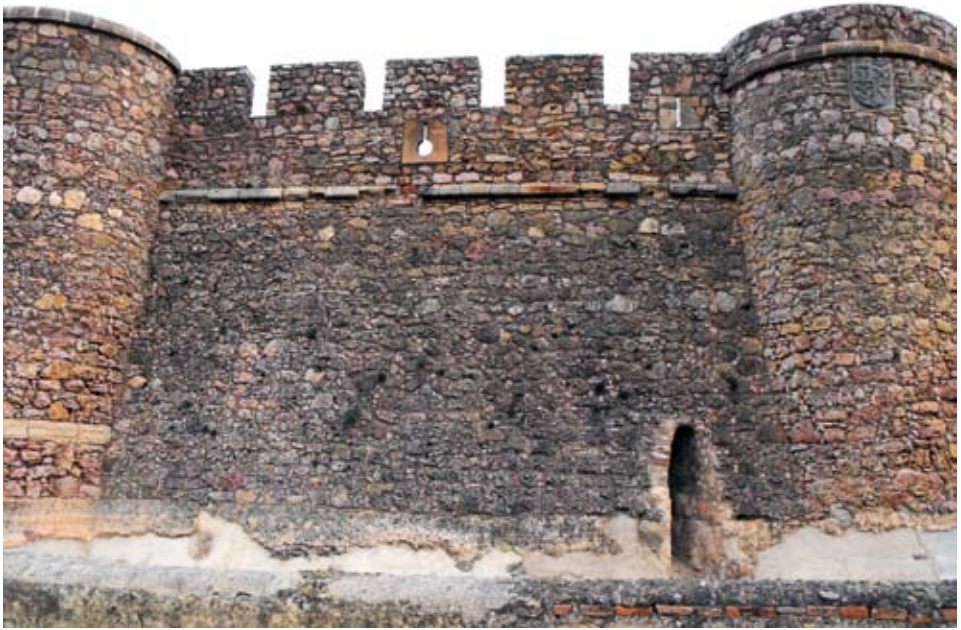
Fig. 10. Lienzo 01, donde se aprecia el vano de salida de agua.
