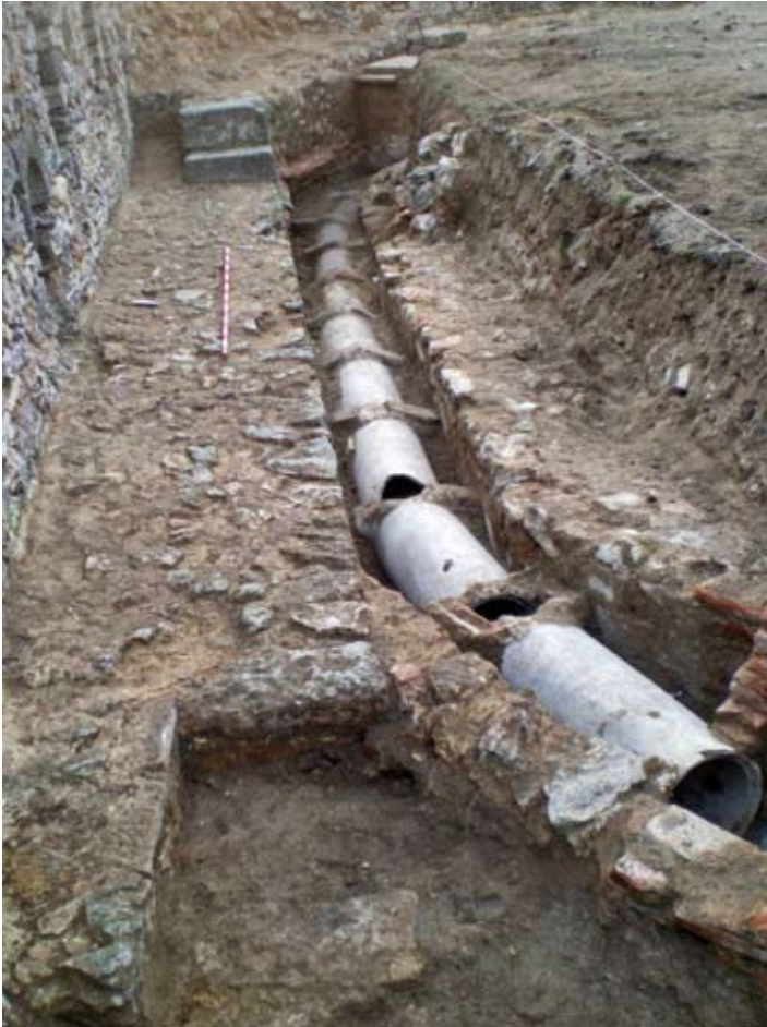
Fig. 8. Tramo de adarve afectado por una canalización de la etapa penitenciaria.
