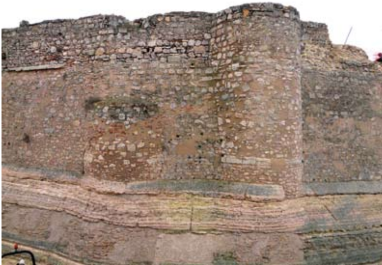
Fig. 12. Lienzo 04, donde se ubicaba una de las puertas originales de acceso.
