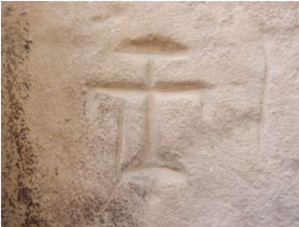
Marca de cantero situada en la parte alta de la torre de la iglesia.
