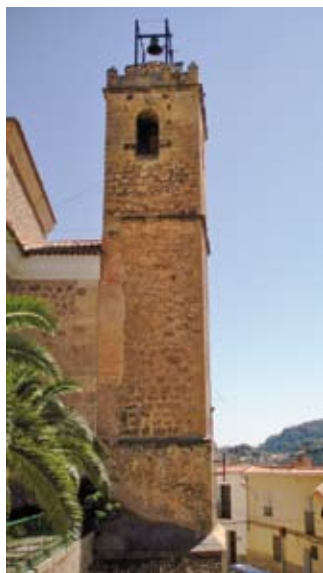
Torre de la iglesia de Santa María de lo Alto. Ayna
