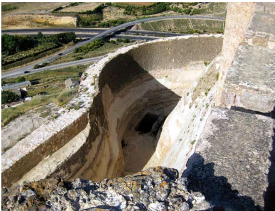
Fig. 5. Aljibe de menores dimensiones localizado en la zona este del foso.
