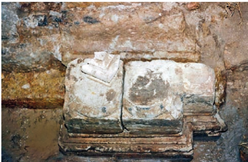
Fig. 15. Triple basa de pilastra sobre plinto en el ángulo este, visible en el interior de la ermita
