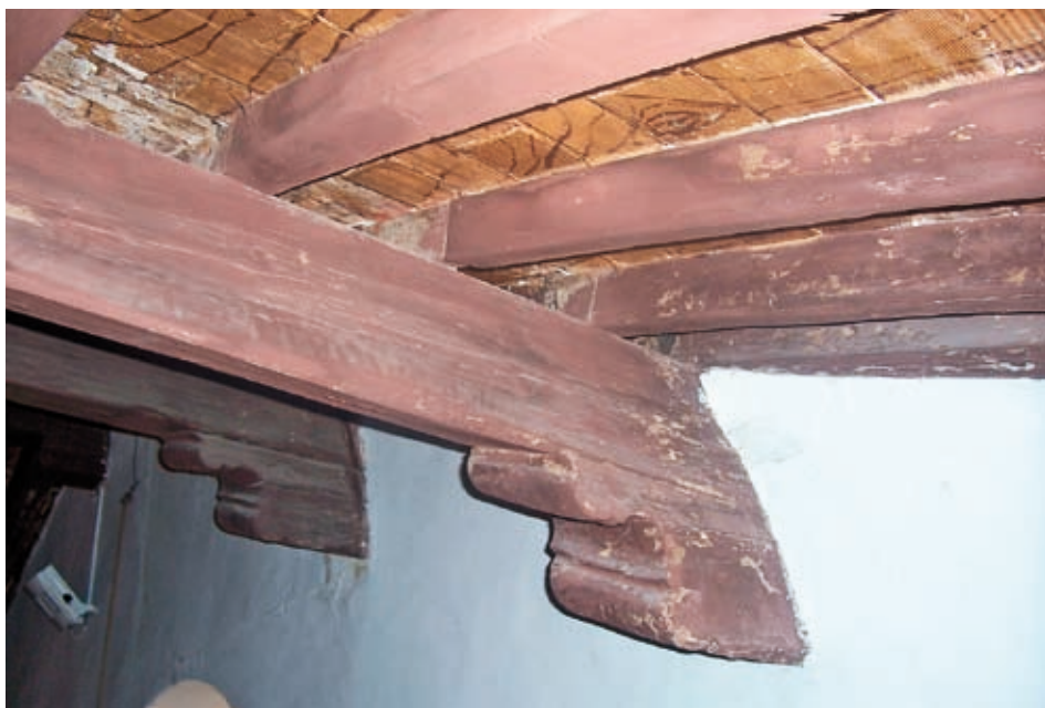
Fot. 4. Detalle de la cubierta
