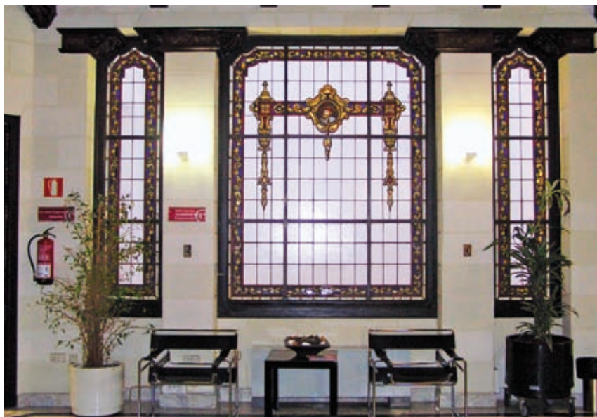
Fot. 12. Ventanales de la planta baja del Chalet Fontecha de Albacete, hoy Cámara de Comercio, cuya disposición se repite en el primer piso. El predominio de cristales translúcidos blancos proporciona al interior mayor luminosidad. Estas vidrieras, se completan con las de las claraboyas del patio central cubierto y escalera principal
