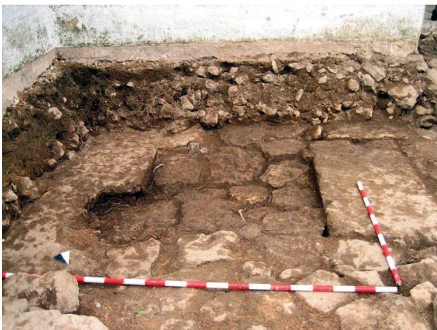
Fig. 6. Zona central del monumento ligeramente vencida
