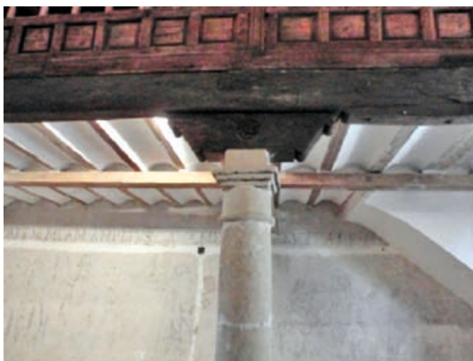
Fot. 3. Zapata central sobre columna toscana
