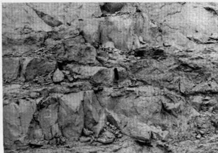
Foto n.º 4: Detalles de las fallas normales en los materiales liásicos de la carretera de Balazote al Jardín.
