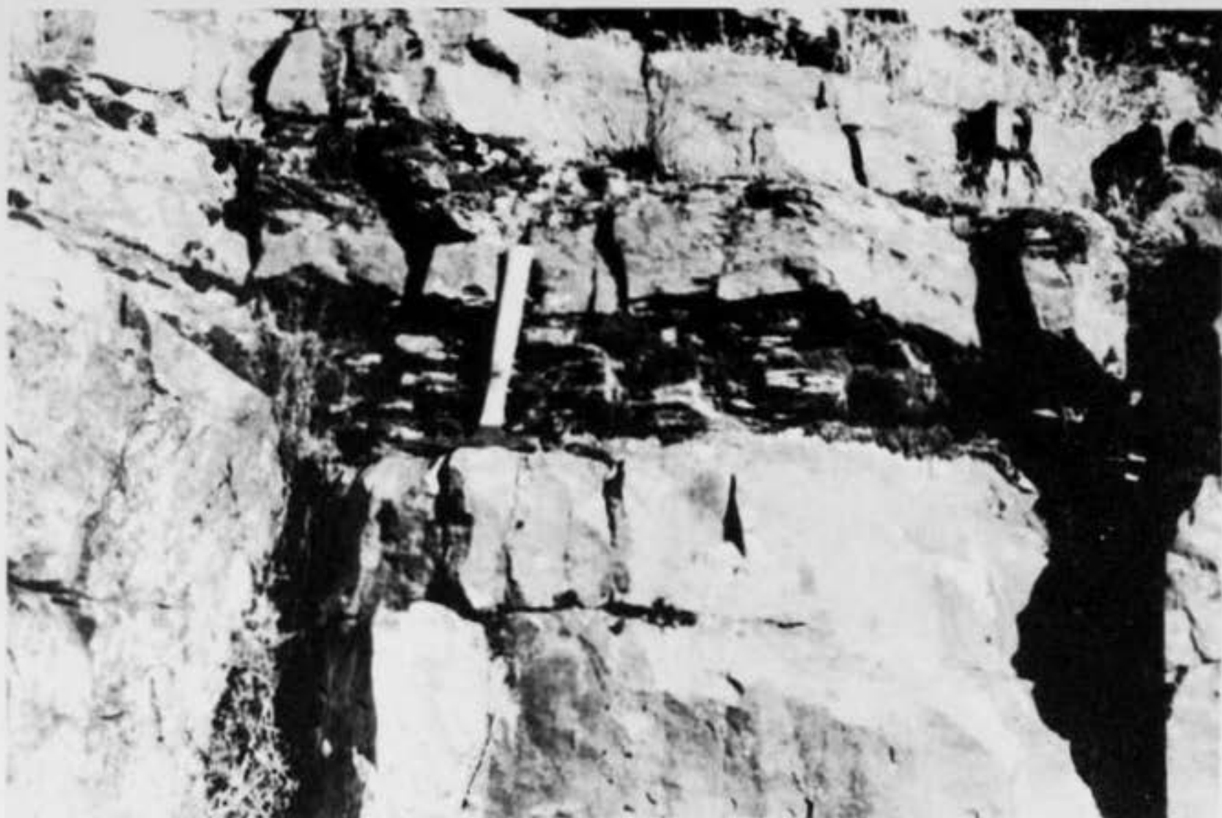
Foto n.º 13: Carretera de Reolid al Salobre: Pizarras intercaladas entre las cuarcitas.
