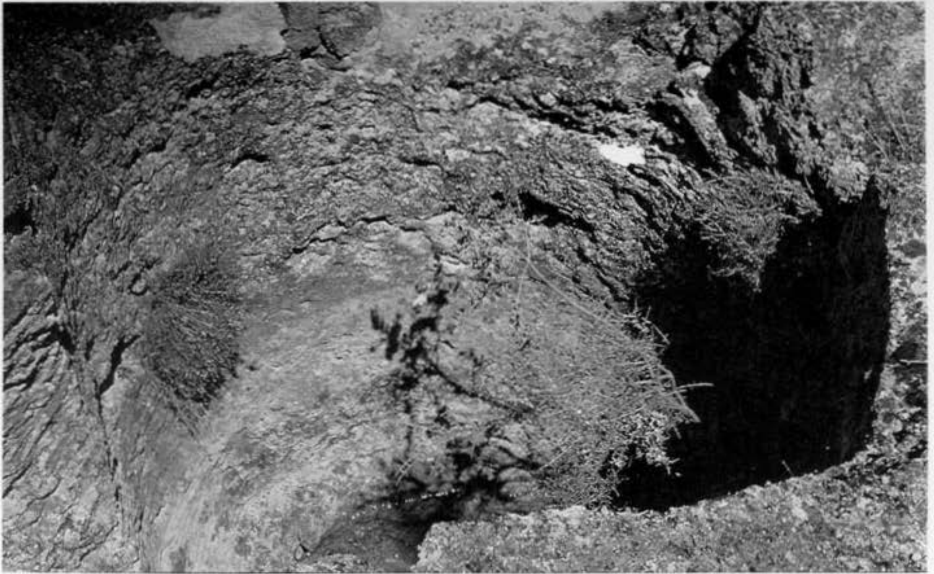
Fot. 8: Pozo excavado en el promontorio rocoso que separa las lagunas Lengua y Salvadora y que era el cubo de presión de uno de los batanes.
