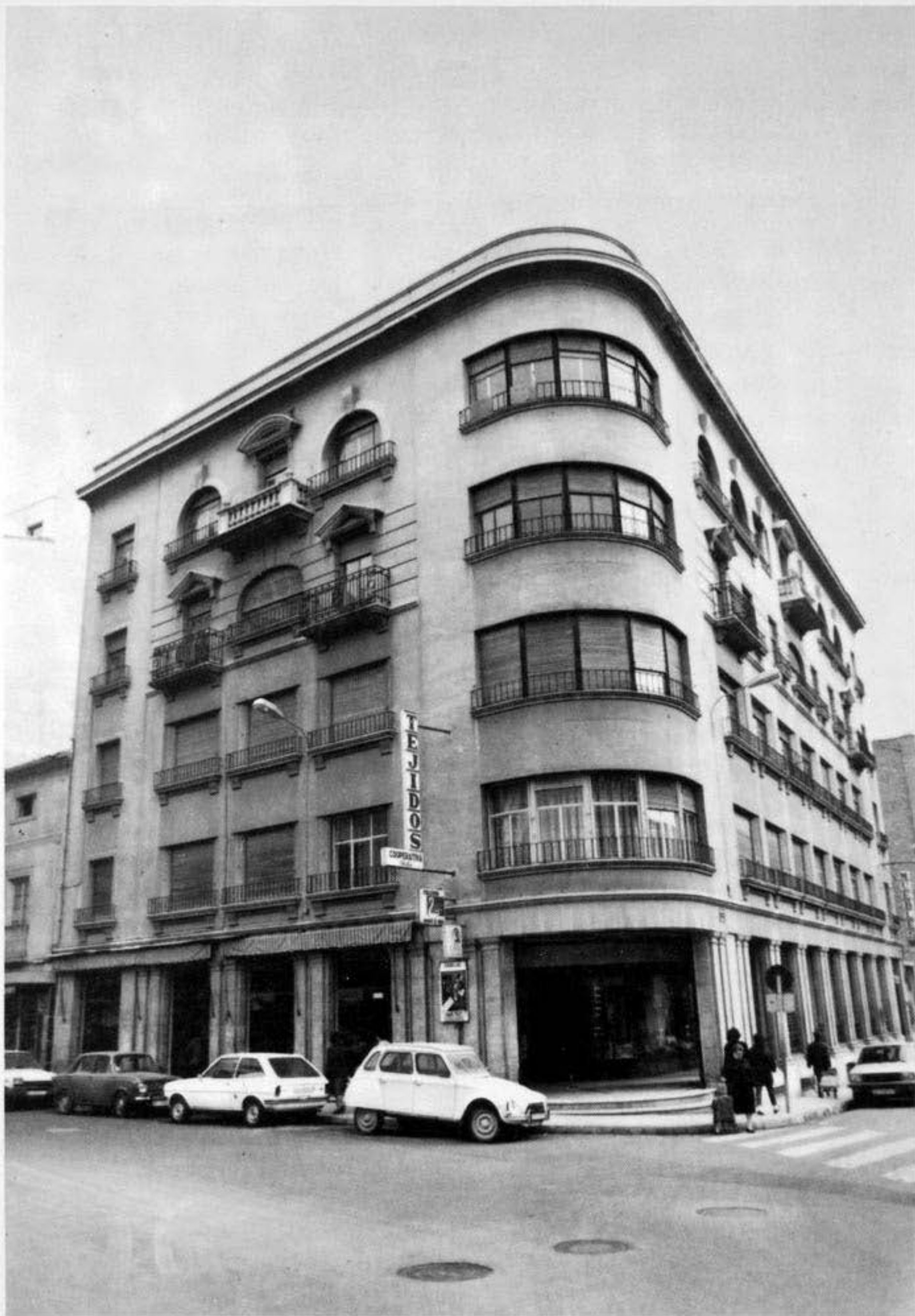
Lám. XIII: Edificio actual de D. Juan Cullell. C/. Tinte 1-3 y Abelardo Sánchez. Miguel Ortiz y Julio Carrilero. Año 1949.
