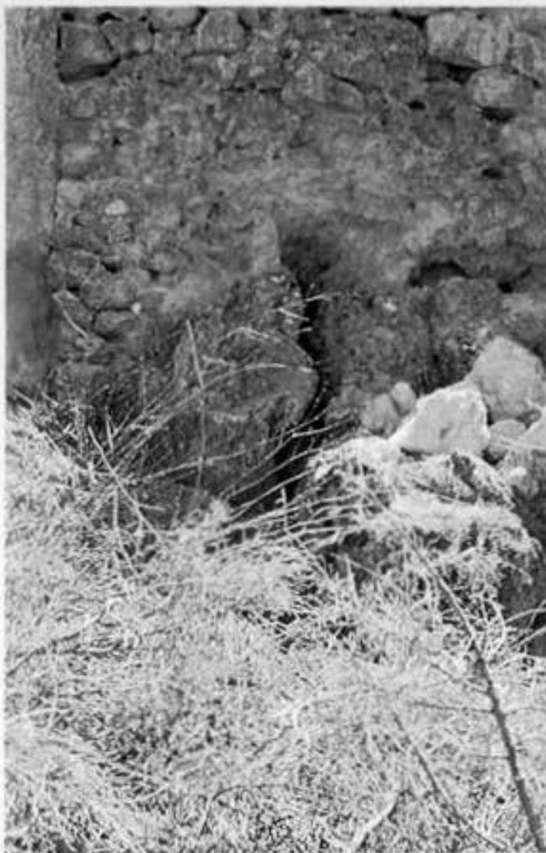
Fot. 4: Restos del batán superior del derrame de la Tomilla. Se aprecia aún una parte de la obra del cubo y la abertura de salida del agua que impulsaba la rueda de corriente emplazada delante.
