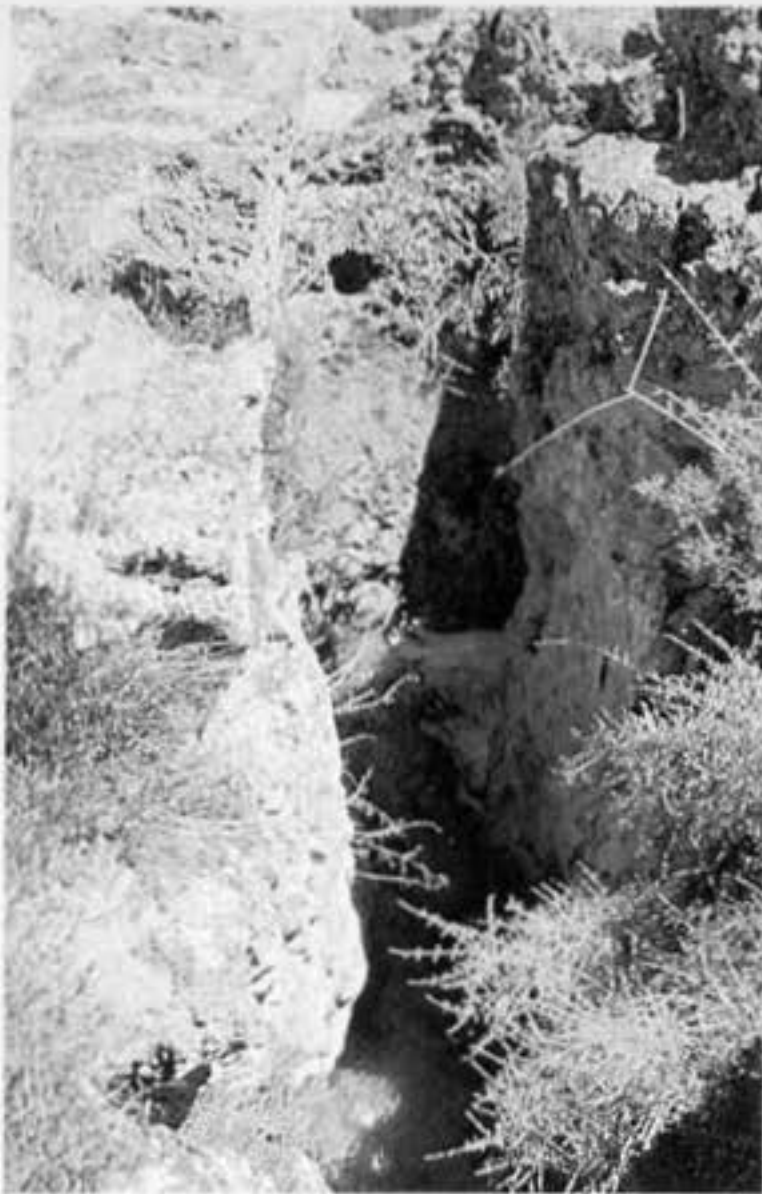
Fot. 6: Aliviadero excavado en la roca de uno de los batanes de la laguna Lengua.
