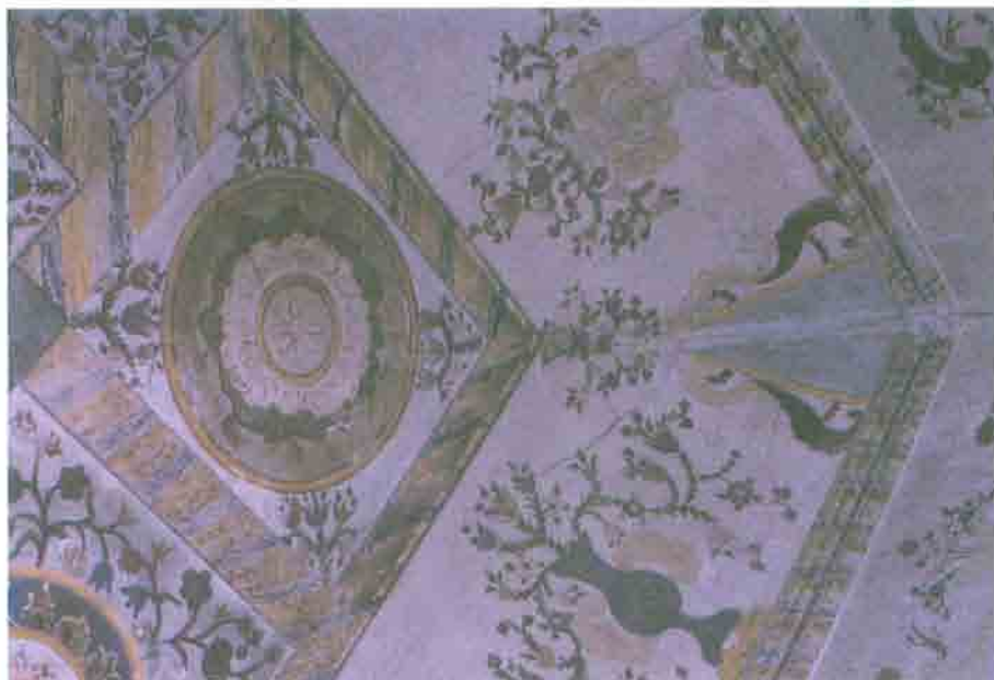
Fot. 7.- Ermita de San Roque, Tarazona de la Mancha. Detalle de las pinturas. (Fot. J. Sánchez Ferrer).
