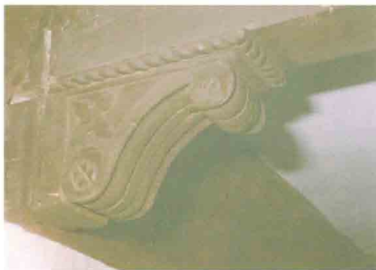
Fot. 15.- Ermita de la Inmaculada-San Blas. Tarazona de la Mancha. Ménsula de la armadura de madera. (Fot. Juan A. Picazo Monteagudo).
