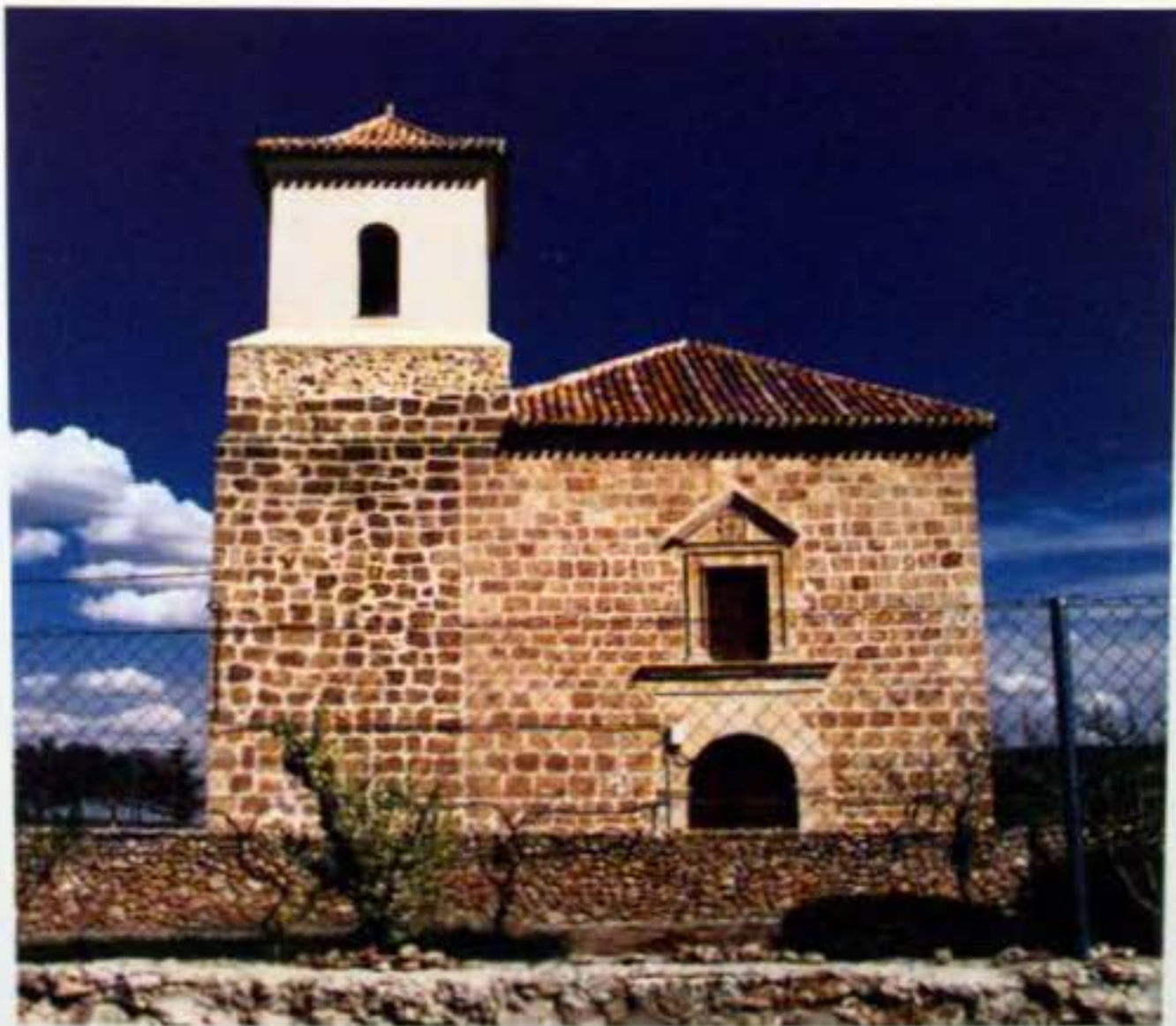
Fot. 4: Fachada principal de la parroquia. Iglesia de la Asunción. Socovos.
