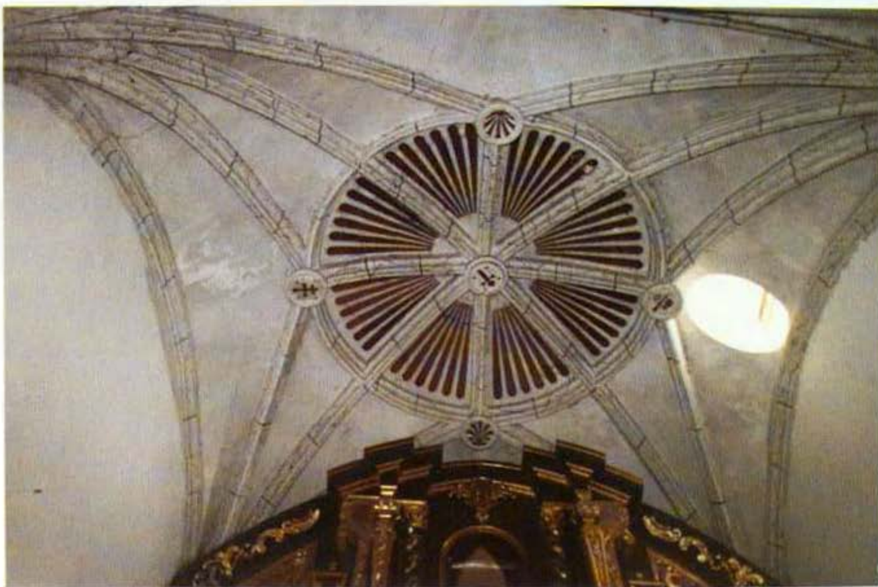
Fot. 25: Bóveda del presbiterio. Iglesia de la Asunción. Ferez.
