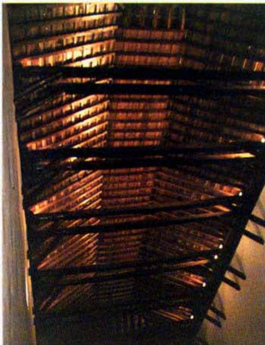
Fot. 7: Cubierta de armadura de tradición mudéjar de la parroquia de la Asunción. Socovos.
