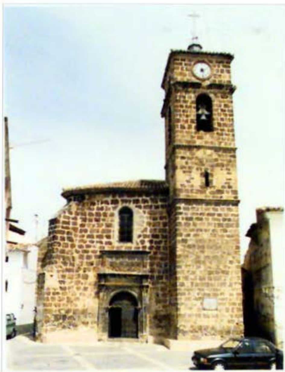
Fot. 17: Fachada principal de la iglesia de la Asunción. Letur.
