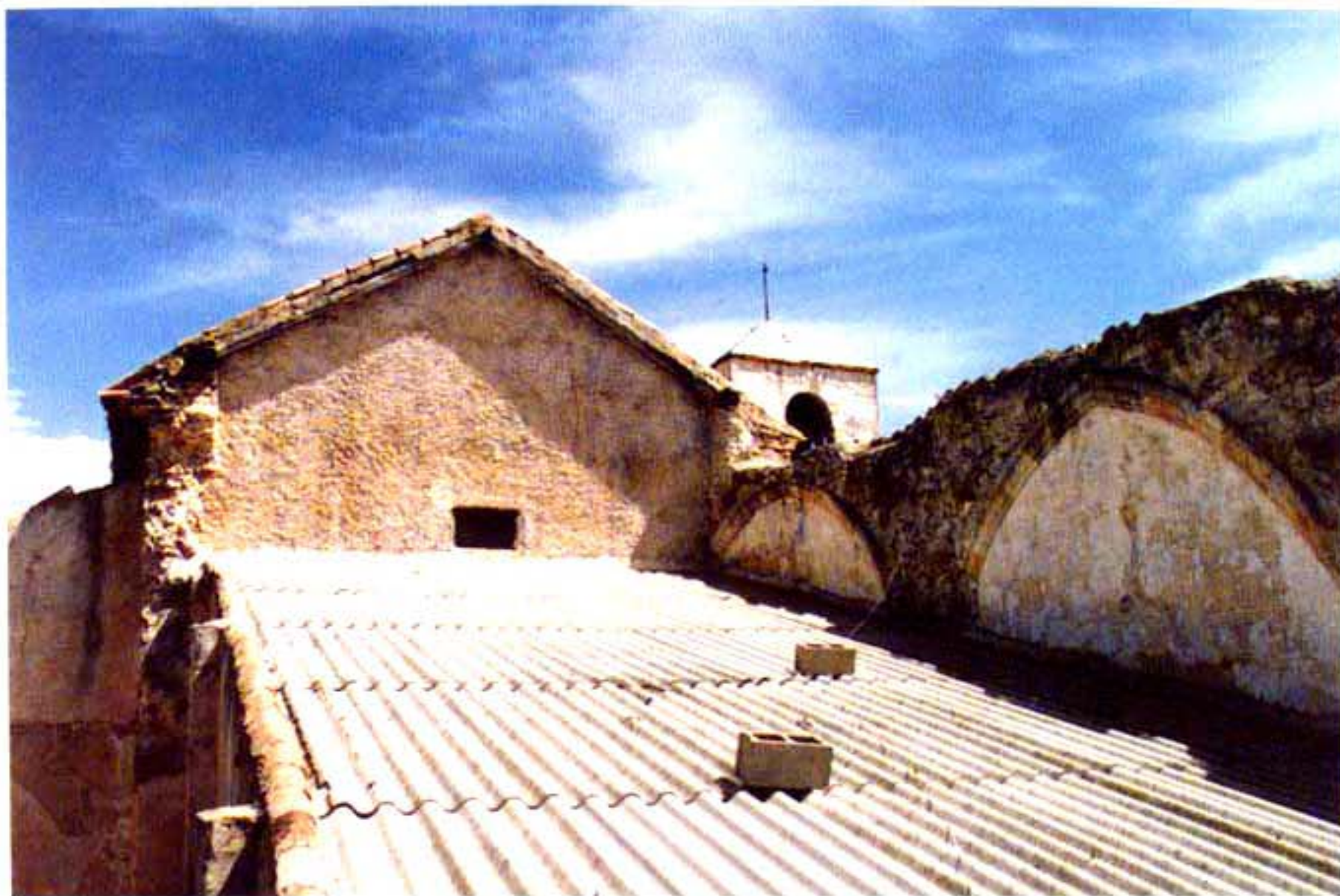
Fot. 23: Tejado de la nave de la iglesia parroquial de Férez.
