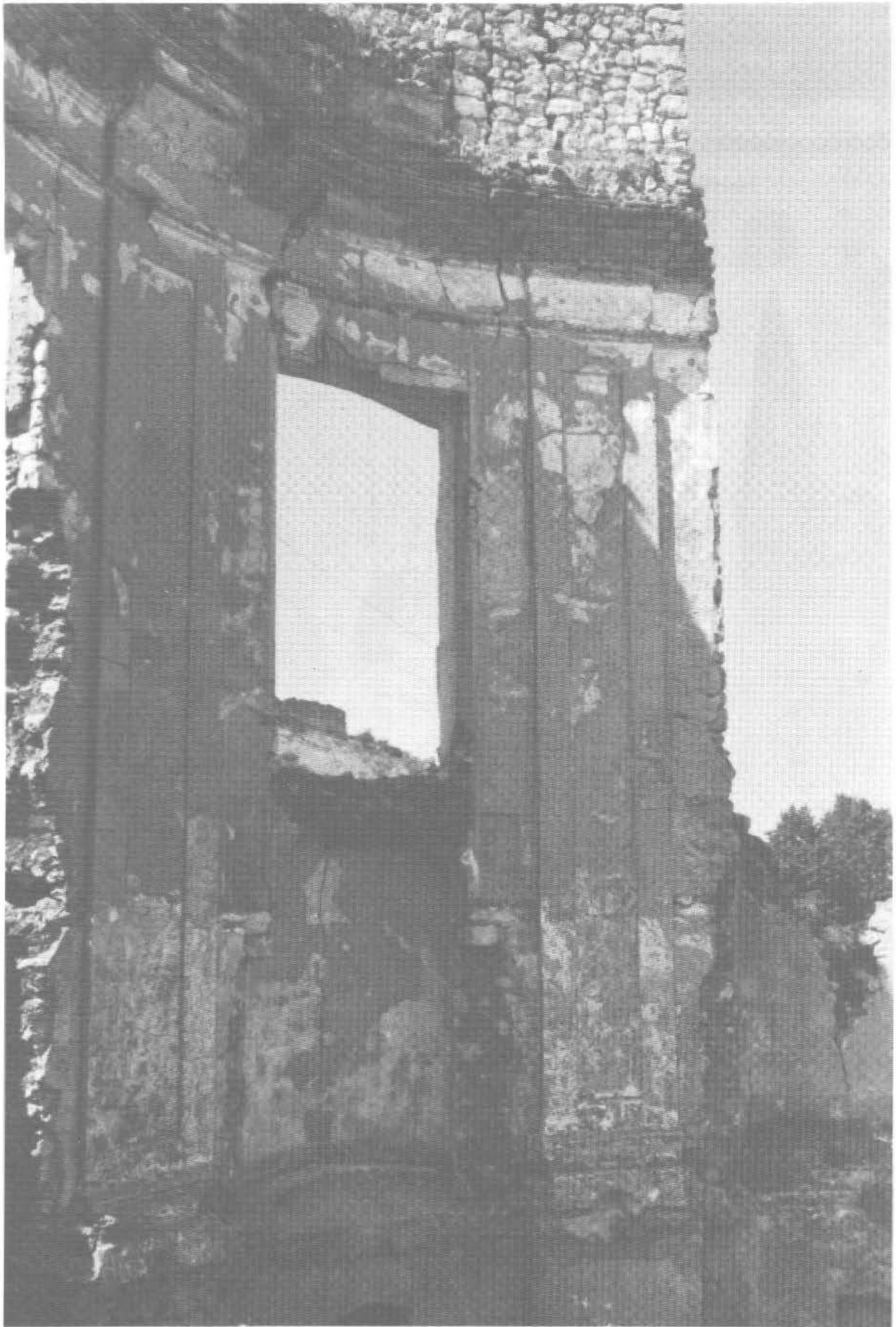
Fig. V. 3. - Monasterio de la Salceda. Detalle del tratamiento de los muros en la Capilla de las Reliquias.
