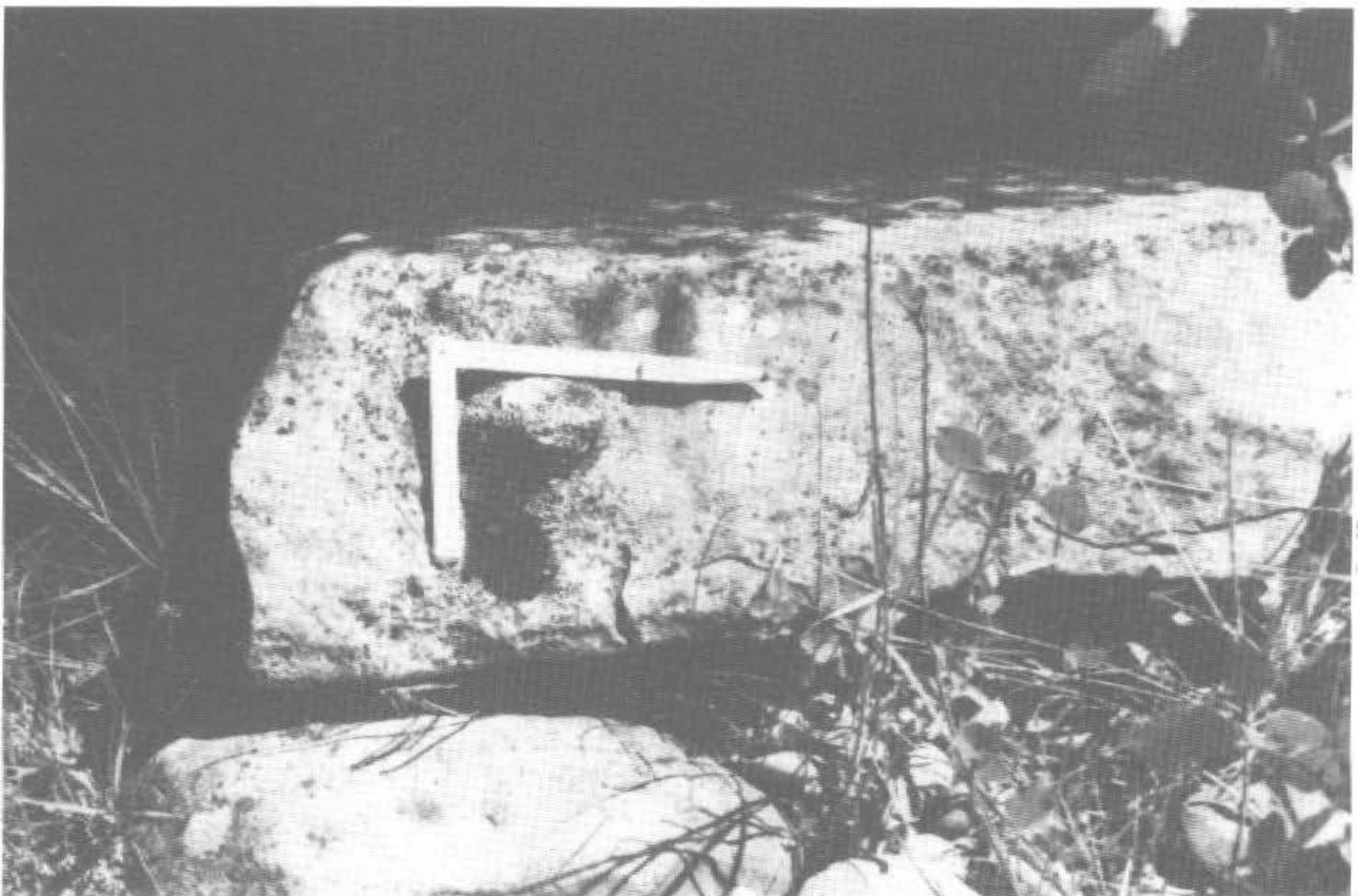
Lámina VI - a) Pilar adosado al molino. Espolón semicircular. b) Sillar. Detalle engarce en "T".
