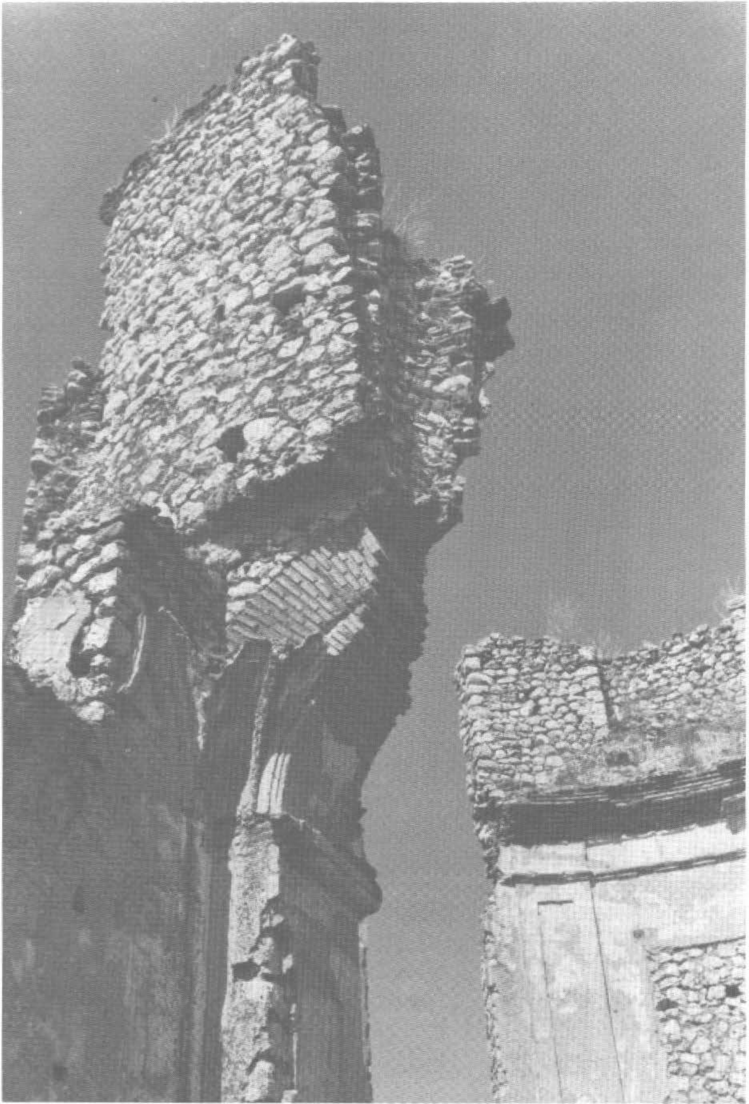
Figura V.1. - Monasterio de la Salceda. Restos de la Bóveda de la Capilla de las Reliquias.
