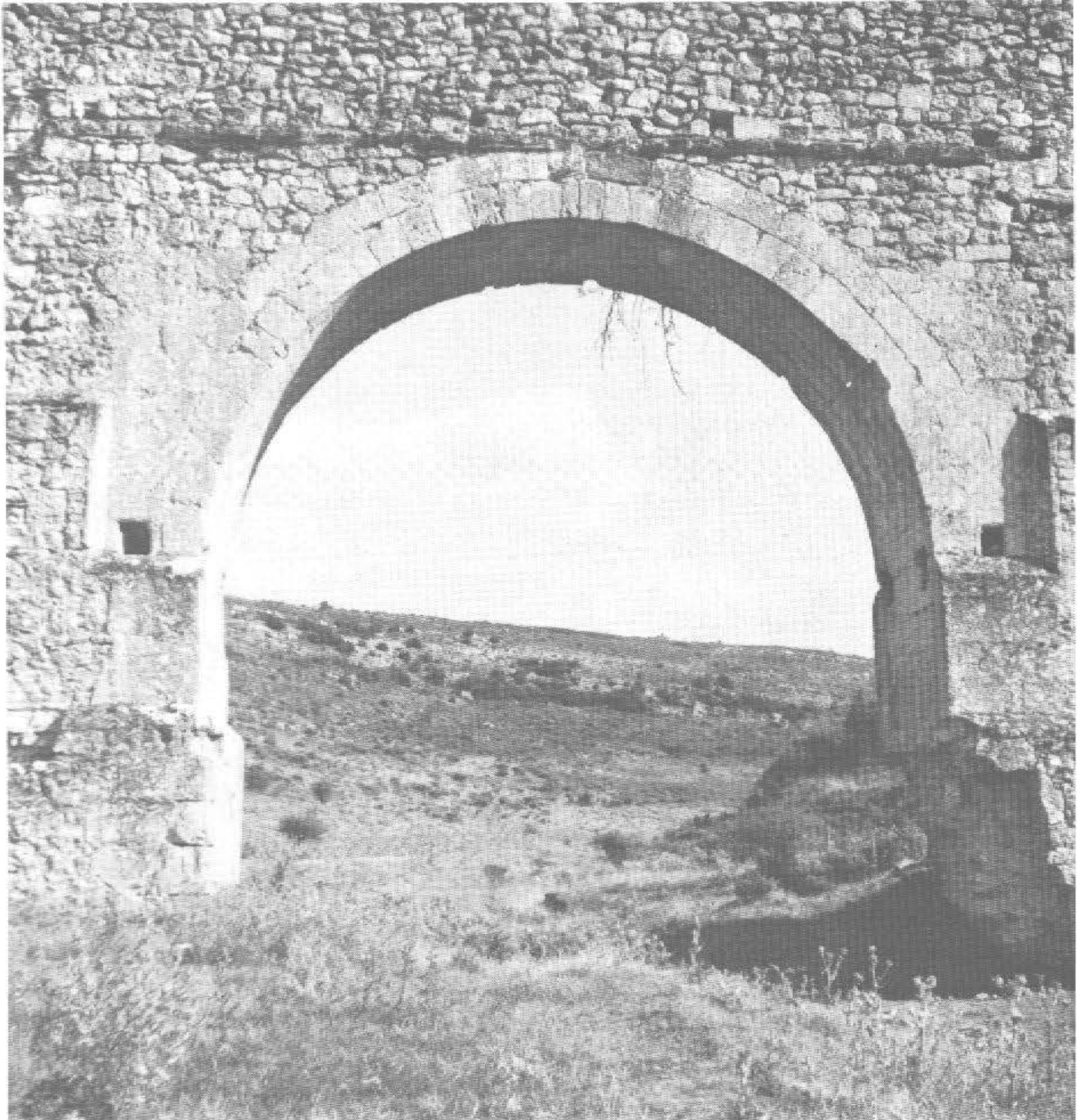
Lámina III - Detalle del arco, fachada Norte. Diferenciación de la mampostería, quadratum -arco, incertum -muro. Doble rosca , y molduras.
