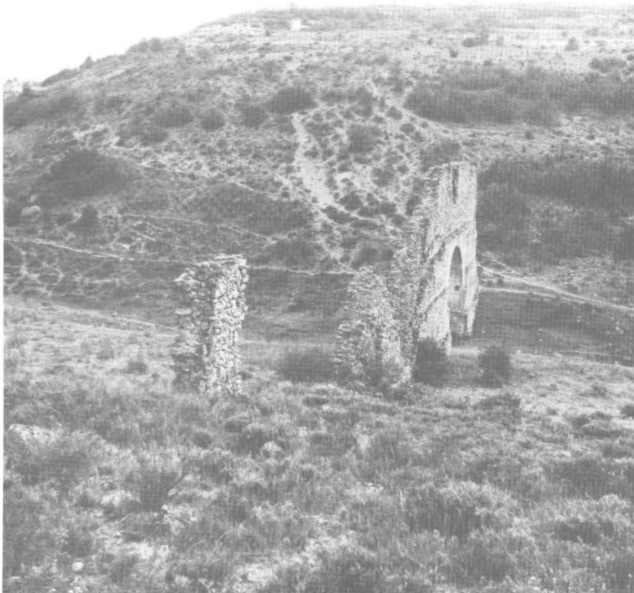
Lámina I - Vista general, fachada Norte. Valoramos su fábrica escalonada, magnitud del arco y hornacina superior. Al fondo, en la cima de la ladera observamos aún una caseta de captación de agua.
