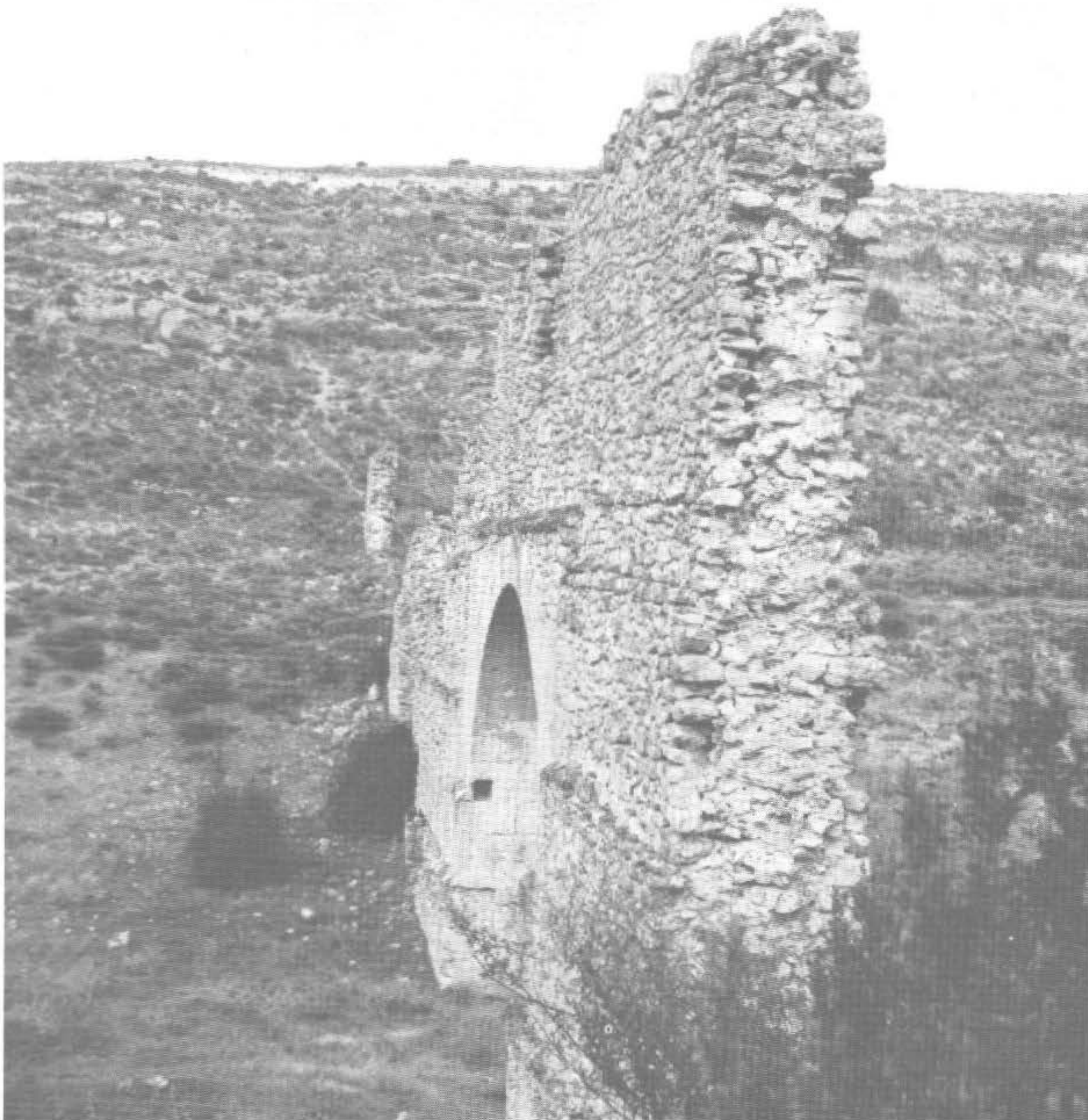
Lámina II - Primer plano, corte practicado en lado Oeste, en cuya sección apreciamos la estructura escalonada, y la composición del muro, opus incertum al exterior y opus caementicium al interior.
