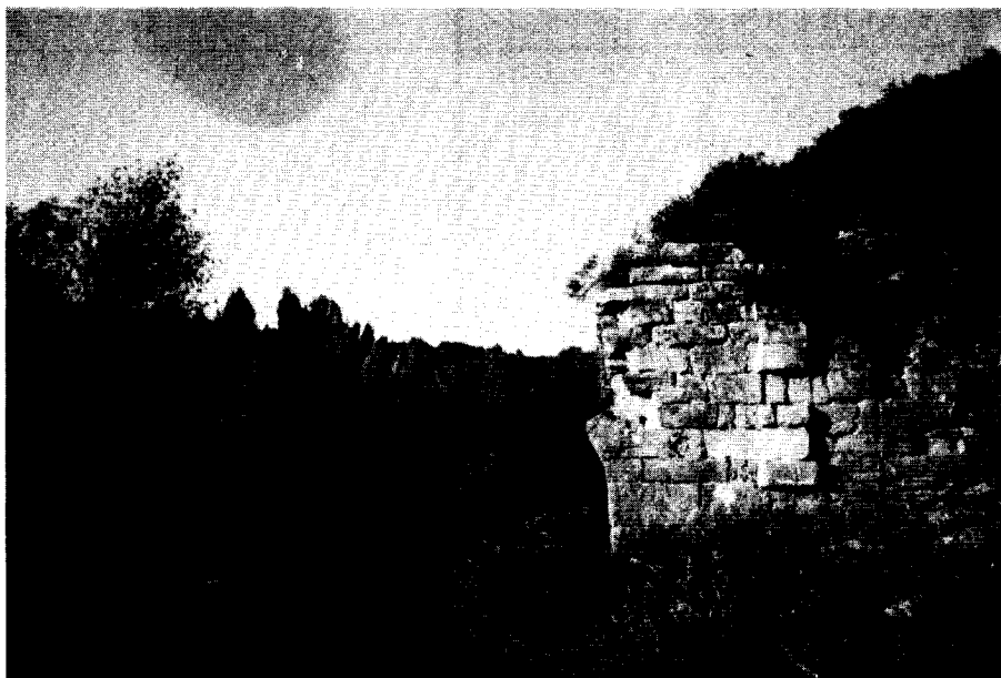
Lámina I. Estribo del puente en la margen izquierda.
