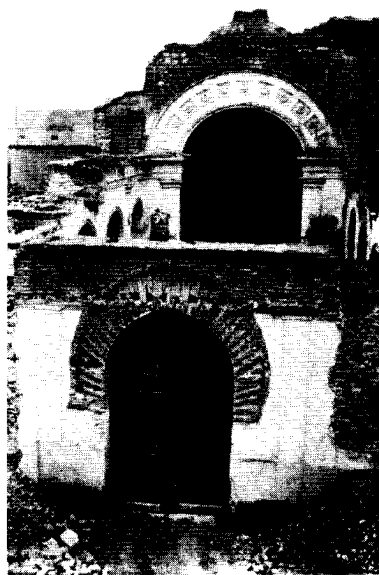
III.- S. Gil (1924). Foto: Goñi. Vista general del templo durante las labores de demolición. Procedencia: Archivo General de la Administración. Alcalá de Henares.
