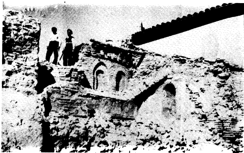
V.- S. Gil (1924). Foto: Camarillo. Obreros demoliendo el ábside. Delante la bóveda de la capilla de los Orozco hundida. Procedencia: Biblioteca de Investigadores de Guadalajara. Excma. Diputación.
