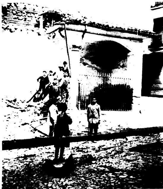
II. bis.- S. Gil (1924). Unico tramo del pórtico no afectado por el desplome del frontón de la nave principal.
