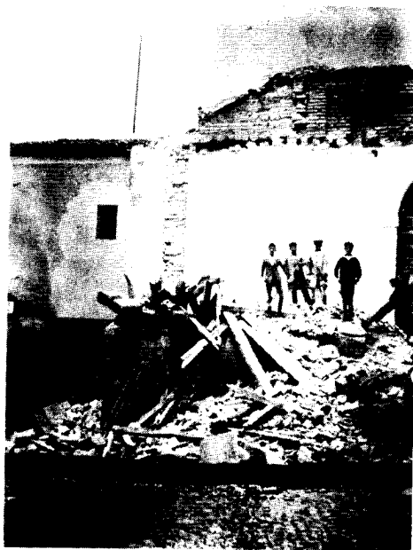
II. - S. Gil (1924). Vista parcial del pórtico derrumbado. En la fachada se permite ver la fábrica original de sus muros.
