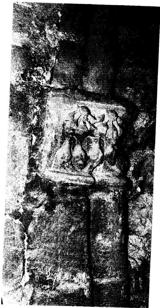
Detalles escultóricos. Ventanal muro norte.
