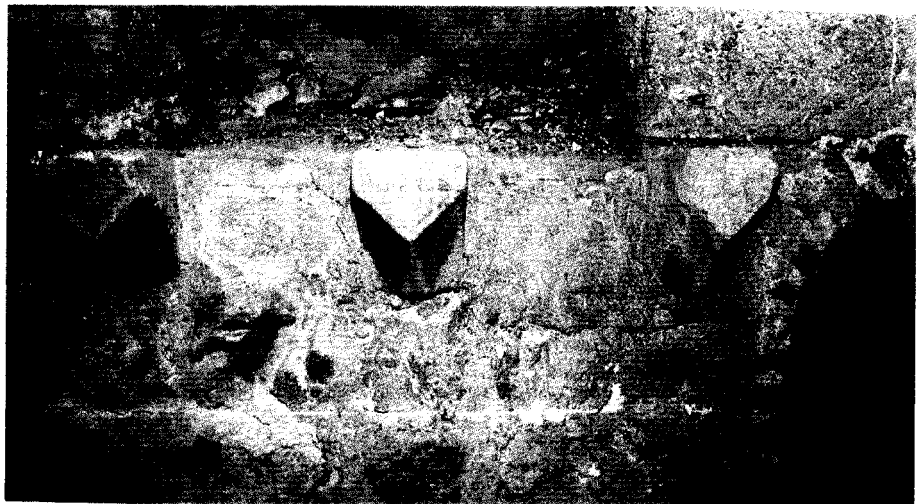
Aspectos del muro sur de la nave.
