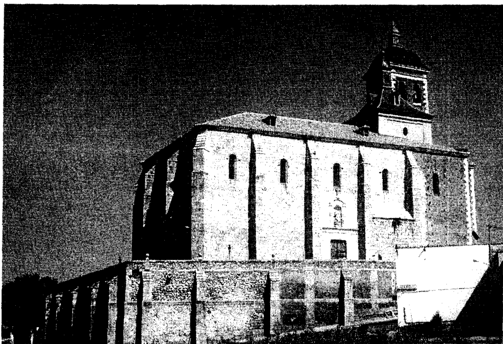
Iglesia de Meco (Madrid) - Exterior.
