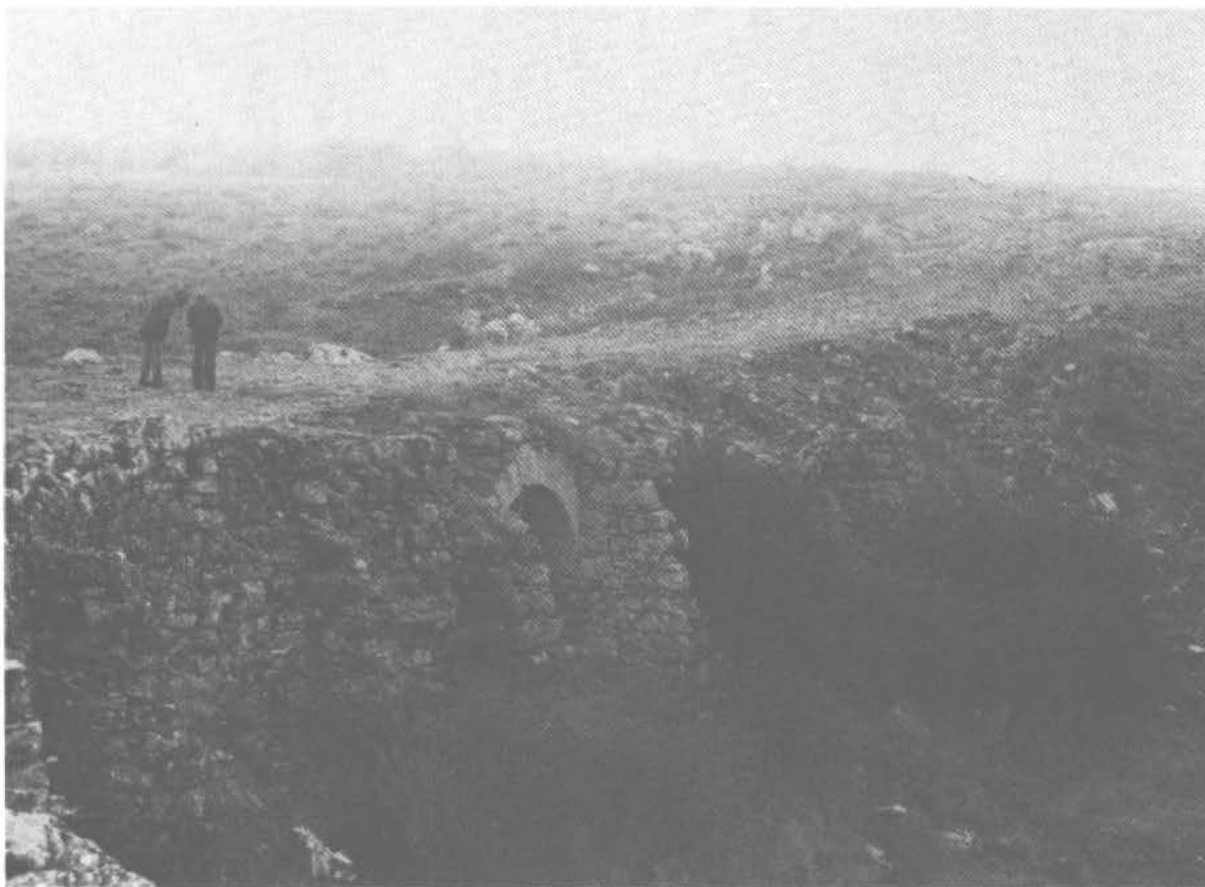
Lám. 1b. La vía cerca de Segontía, sobre el puente antiguo, hoy reformado.
