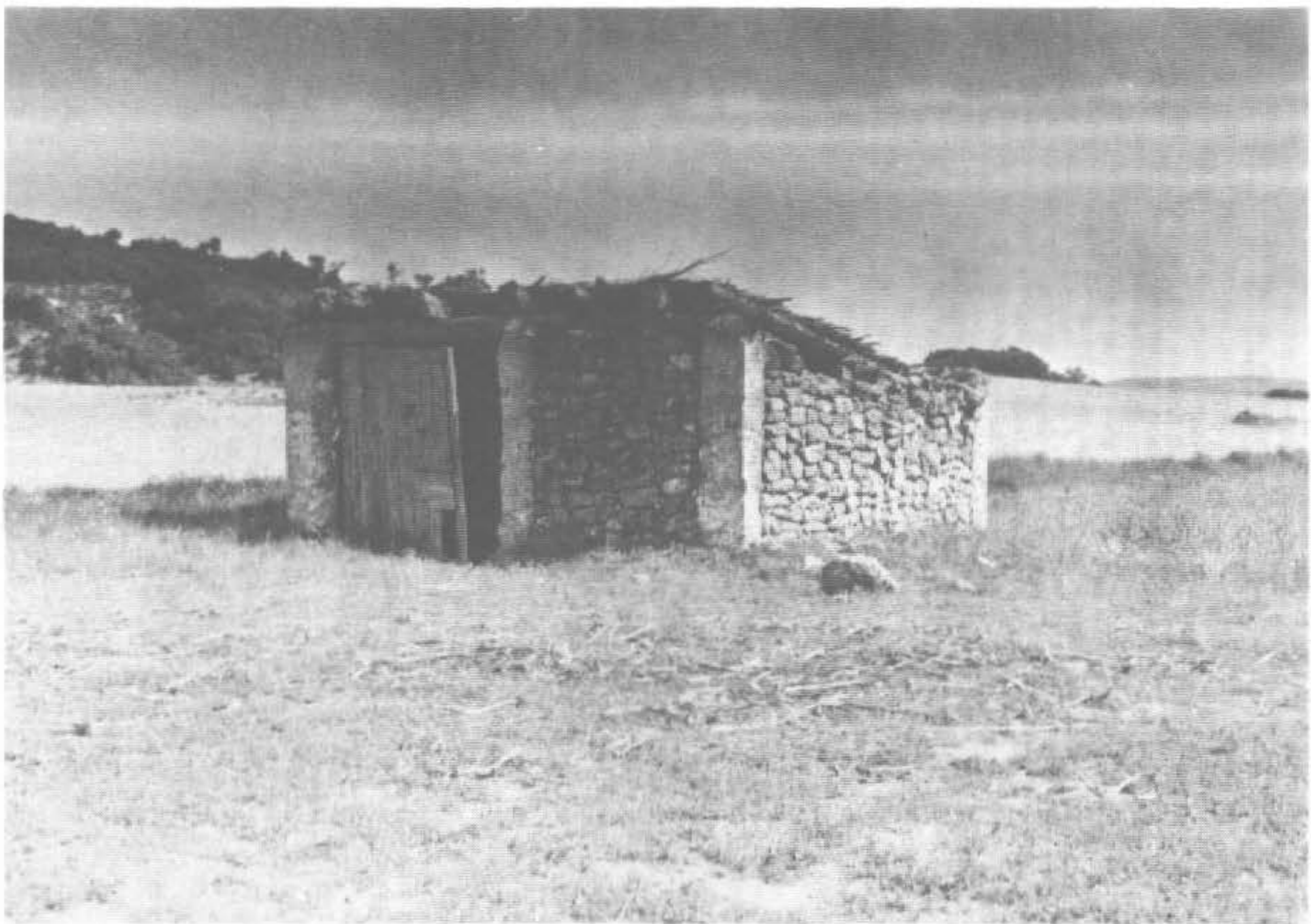
Lám. 8b. Cobertizo, frente y lateral.
