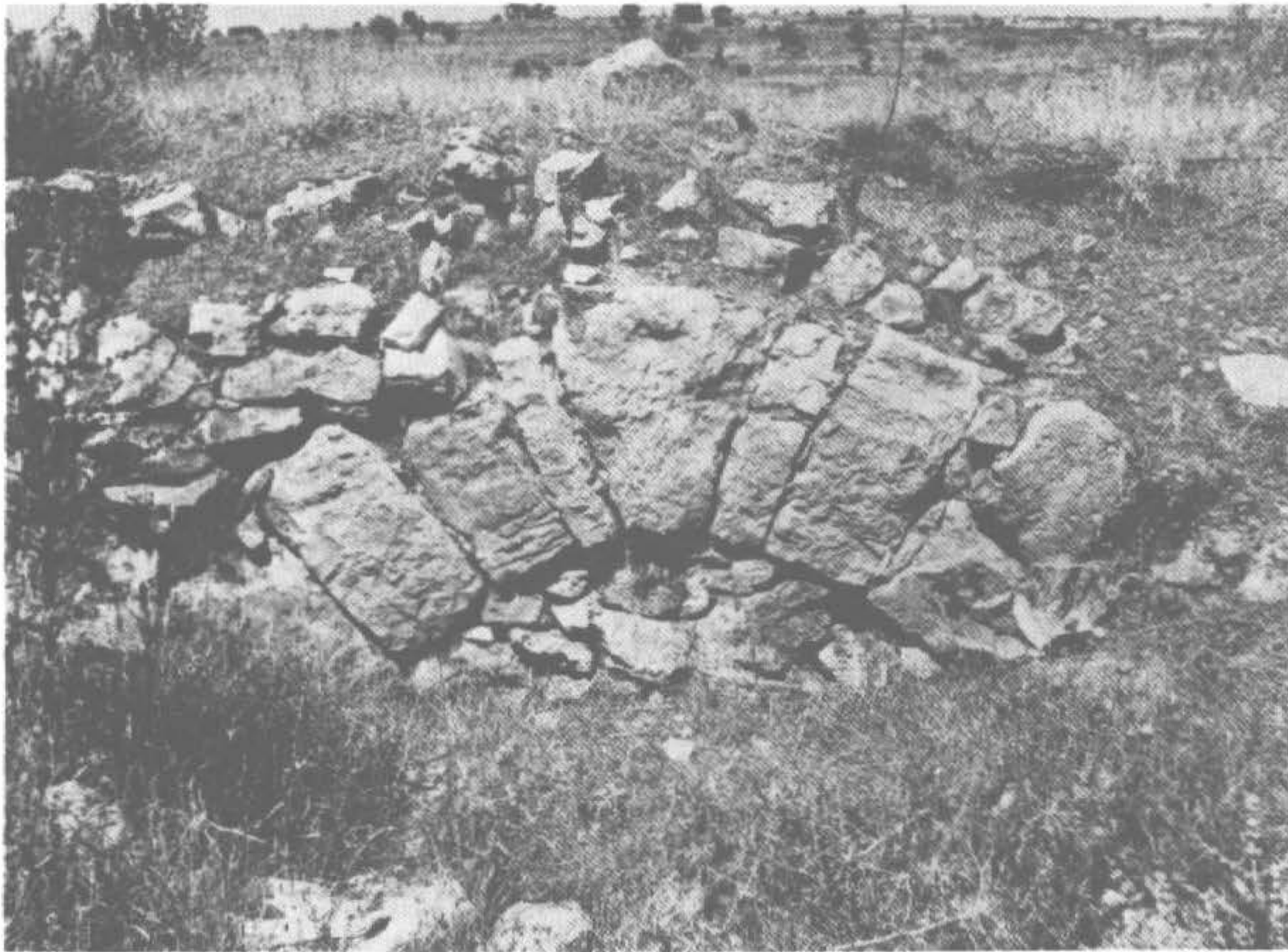
Lám. 1a. Alcantarilla bajo la vía en las proximidades de Segontía.
