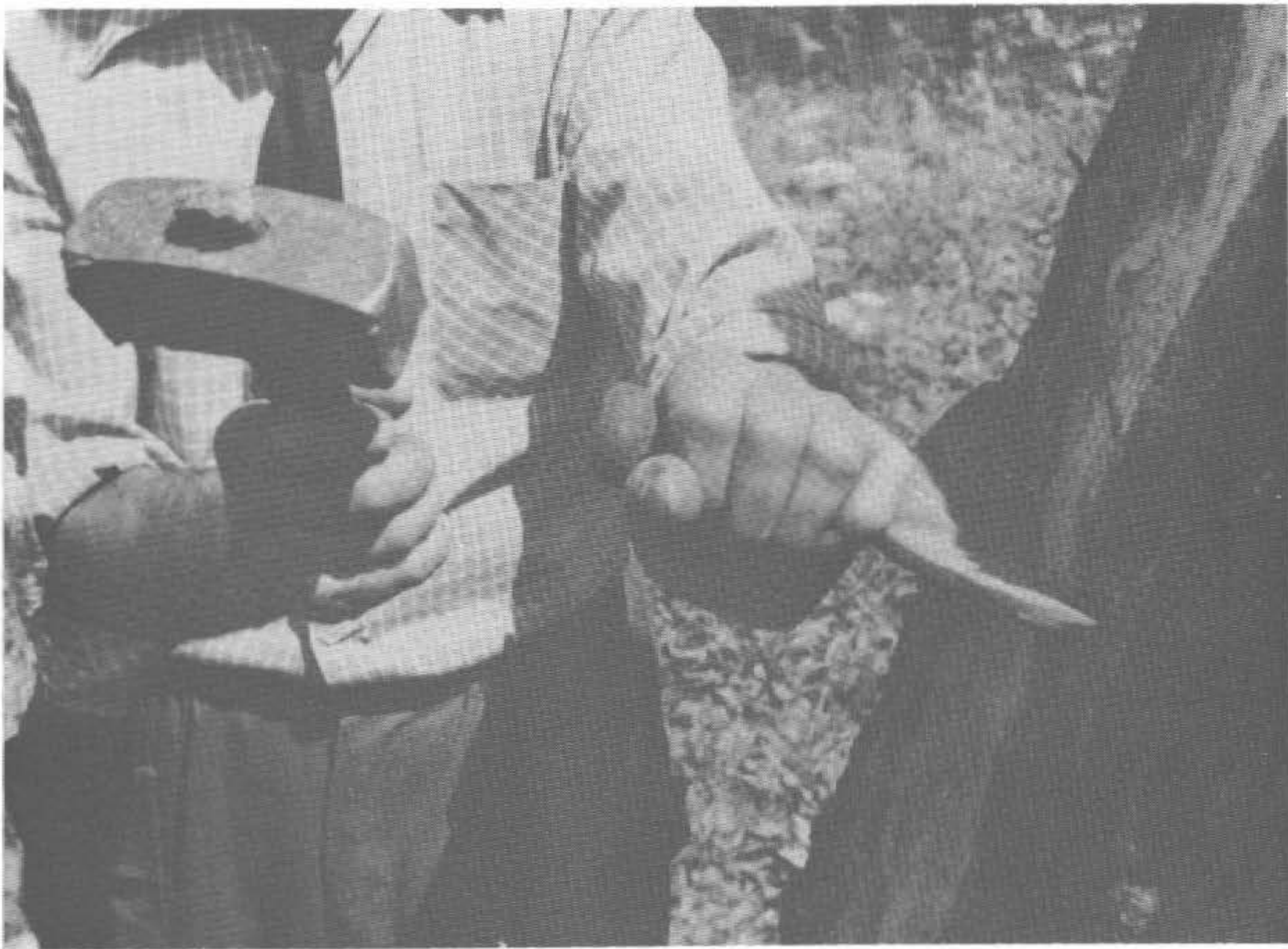
Lám. 1 b: La clavazón se inicia con la media luna y la maza.
