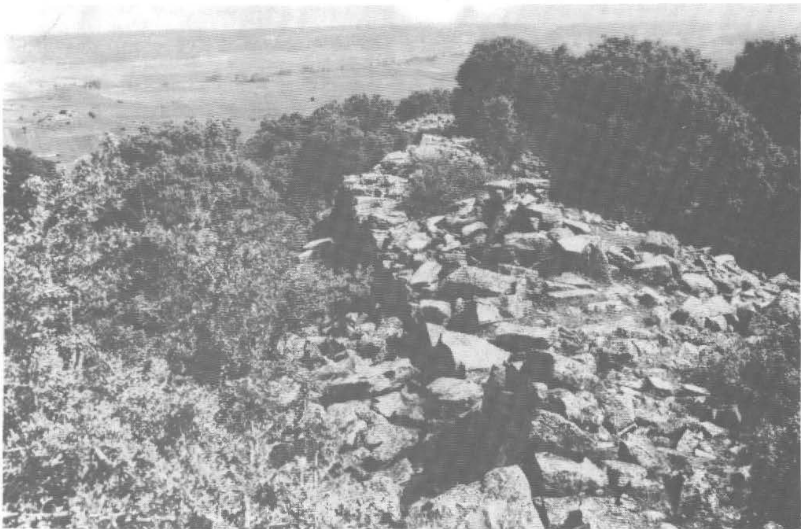
(Lám. VI). Vista superior de la muralla tomada de sur a norte, aproximadamente.
