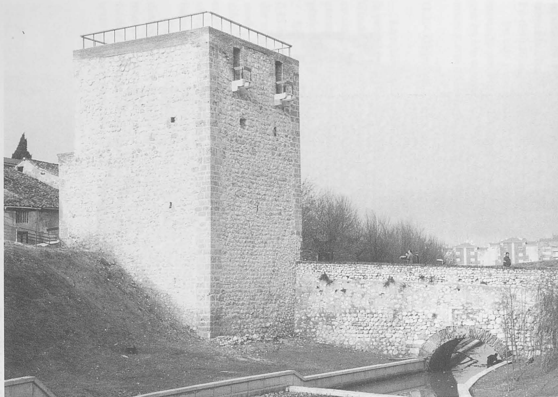
Lámina II. TORREÓN DEL ALAMÍN. Centro de Interpretación de las Murallas Medievales de Guadalajara. Aspecto exterior de la defensa una vez finalizadas las obras del proyecto para su puesta en valor.
