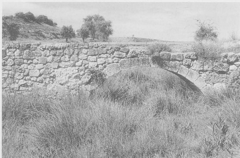
Figura 2.- Reparación moderna en la cara Este
