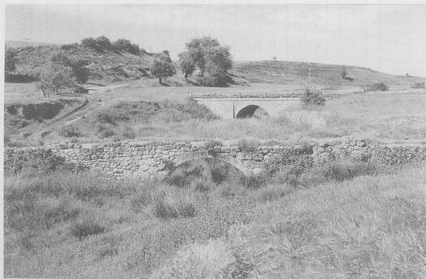
Figura 3.- Vista desde el Este del puente medieval y del puente moderno
