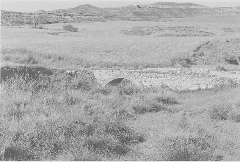
Figura 1 - A.- El Puente de «La Paloma» visto desde el Oeste
