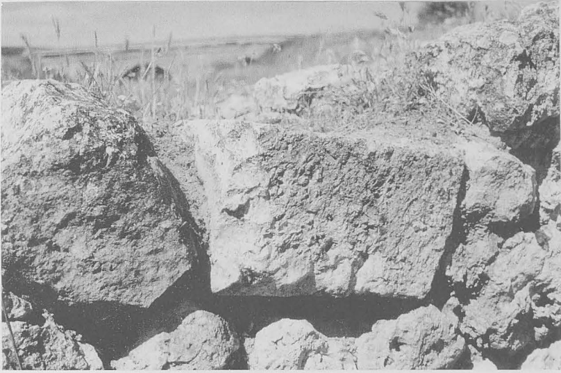
Figura 4 - A.- Reutilización de sillares en las reparaciones
