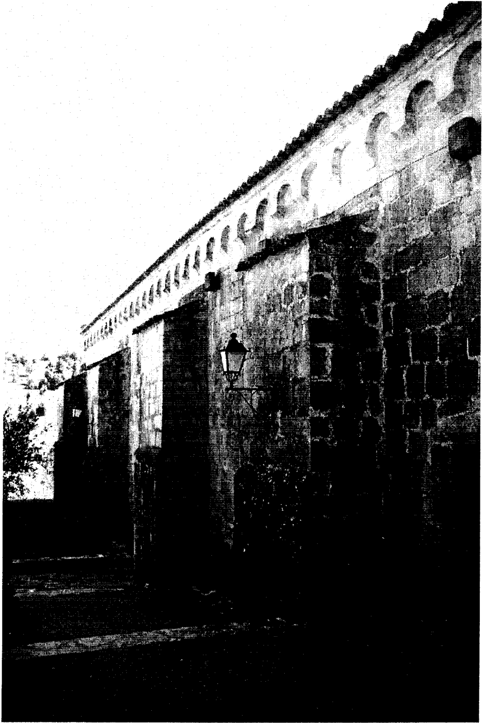
6. Vista general de la fachada norte de la iglesia.
