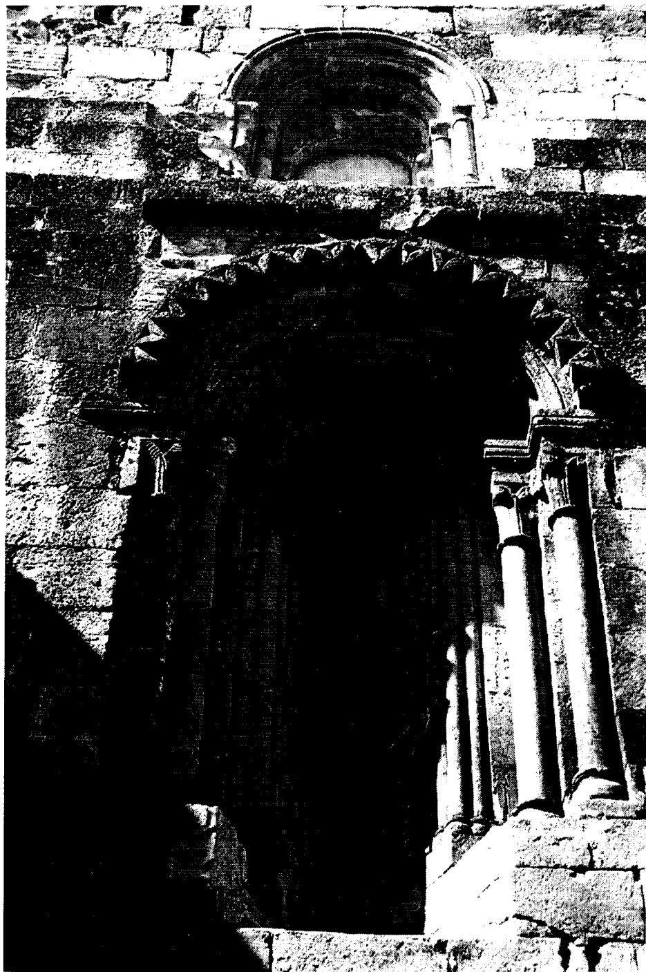
9. Fachada este. Detalle de las ventanas del ábside.
