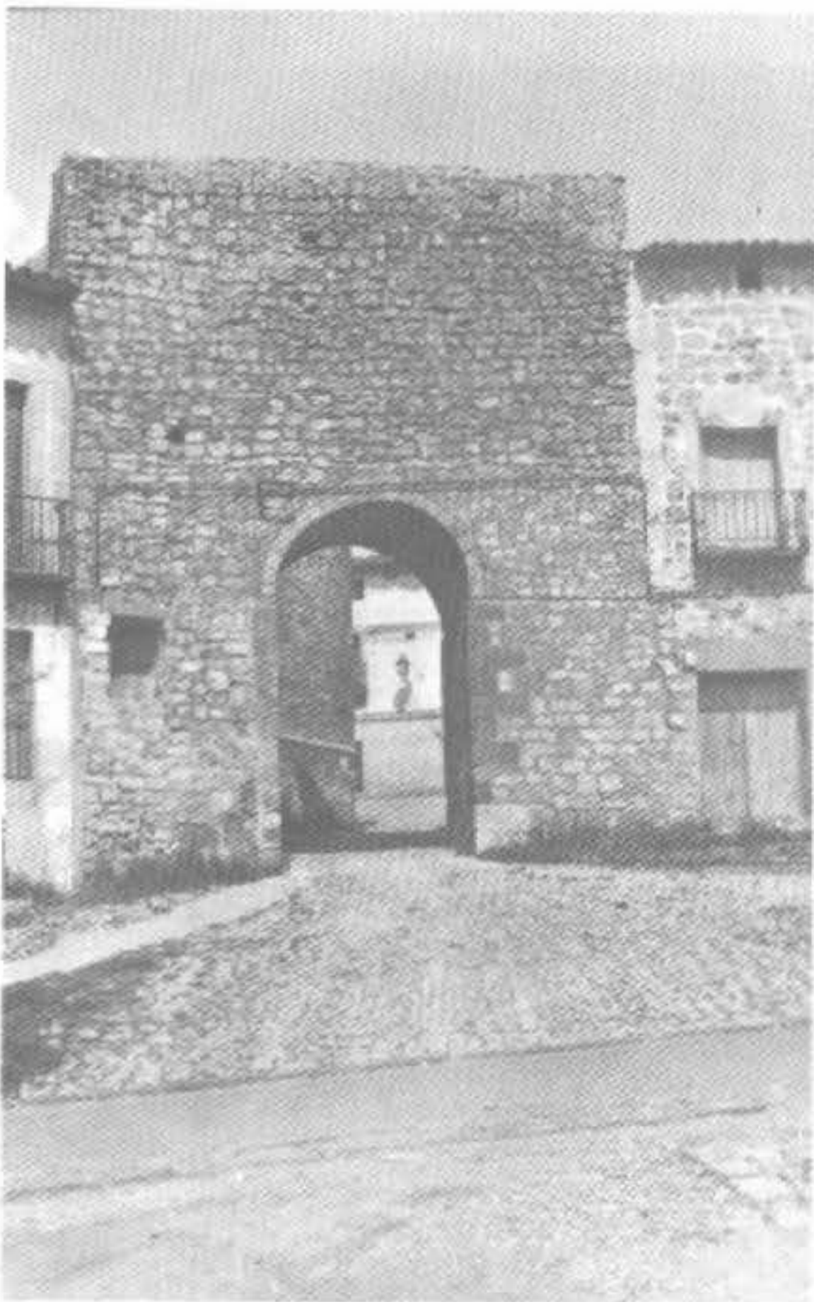
Portal Mayor. Aspecto desde el exterior.
