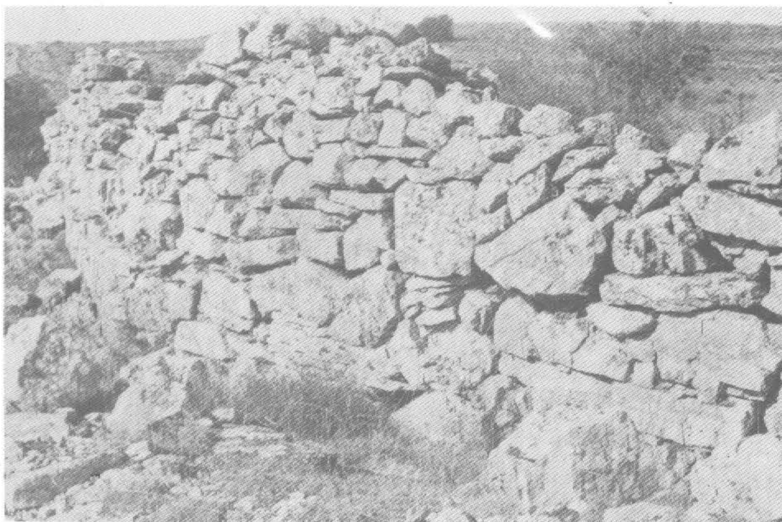
(Fig. 6) Fragmento de muro del ángulo Suroeste. Sobre la antigua cimentación se ha superpuesto un muro de abancalamiento.
