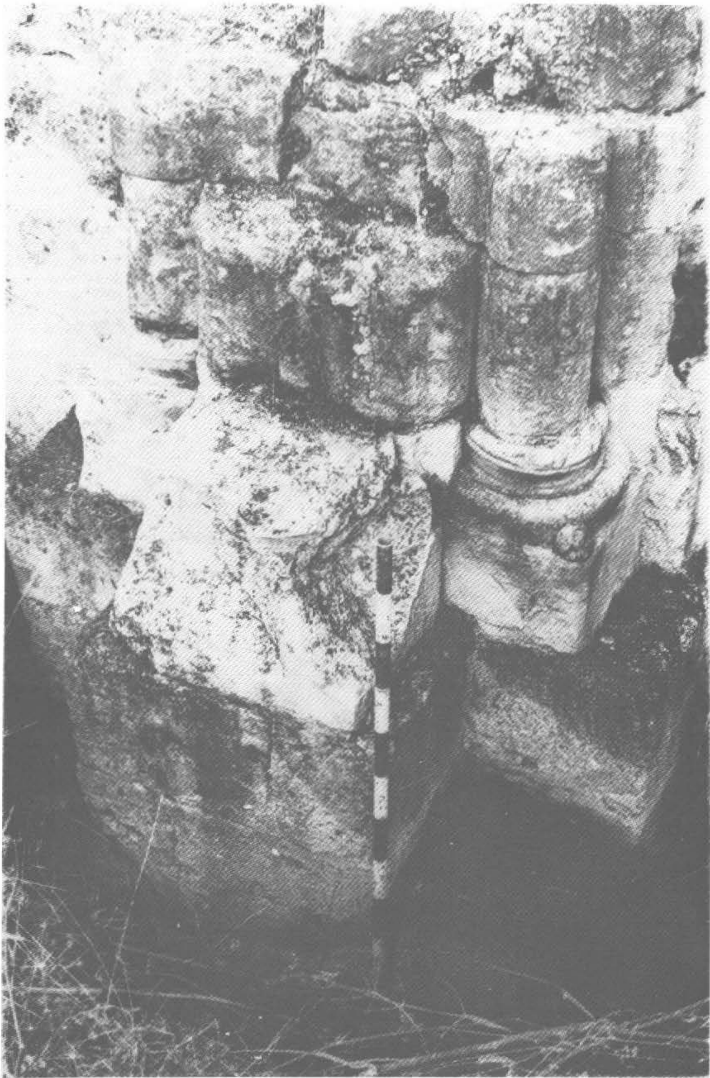
Fig. 8.- Restos que se conservan de la iglesia de San Pedro en Brihuega. Arranque norte del arco triunfal, puesto al descubierto en 1976.
