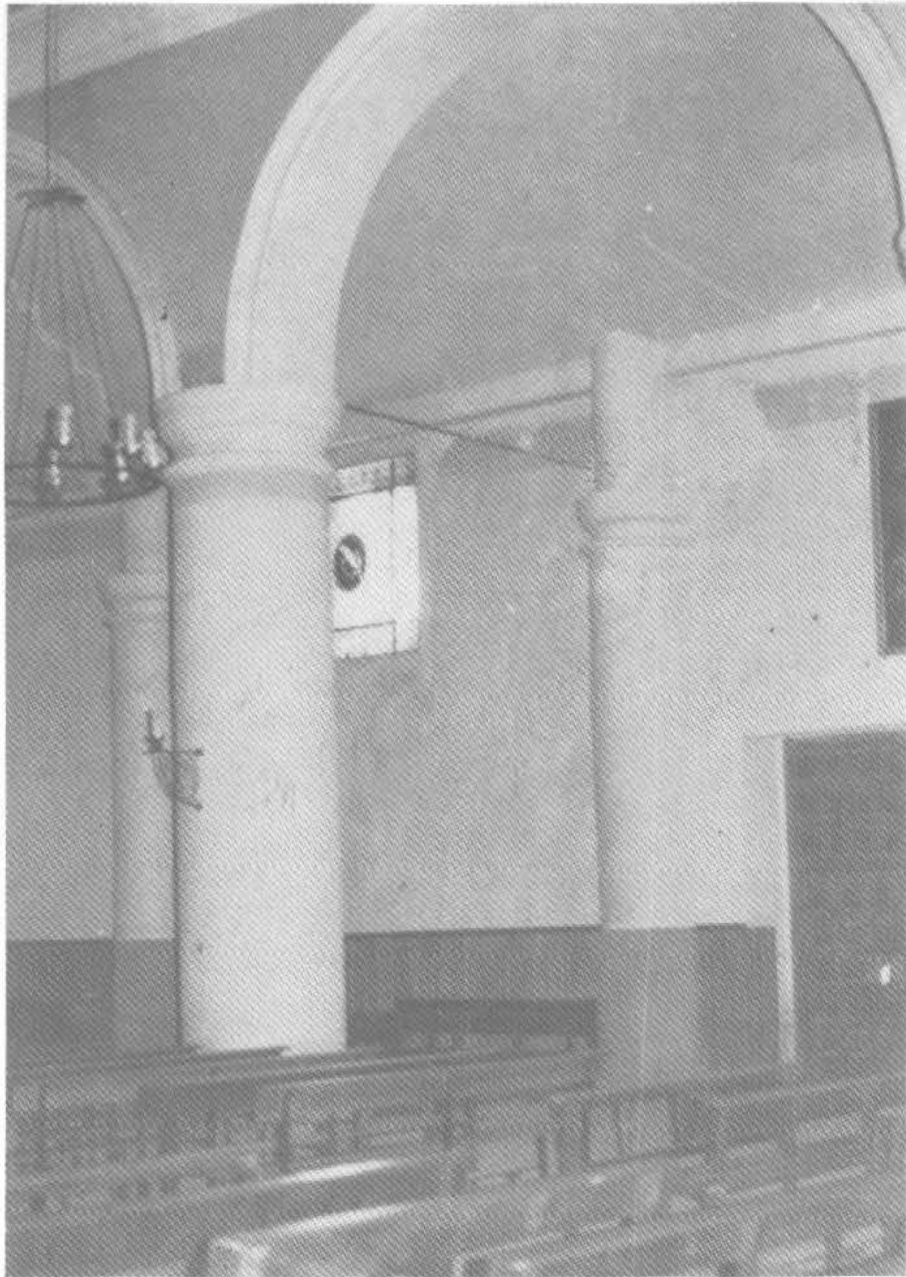
Fig. 3.- Iglesia de Chiloeches. Interior.
