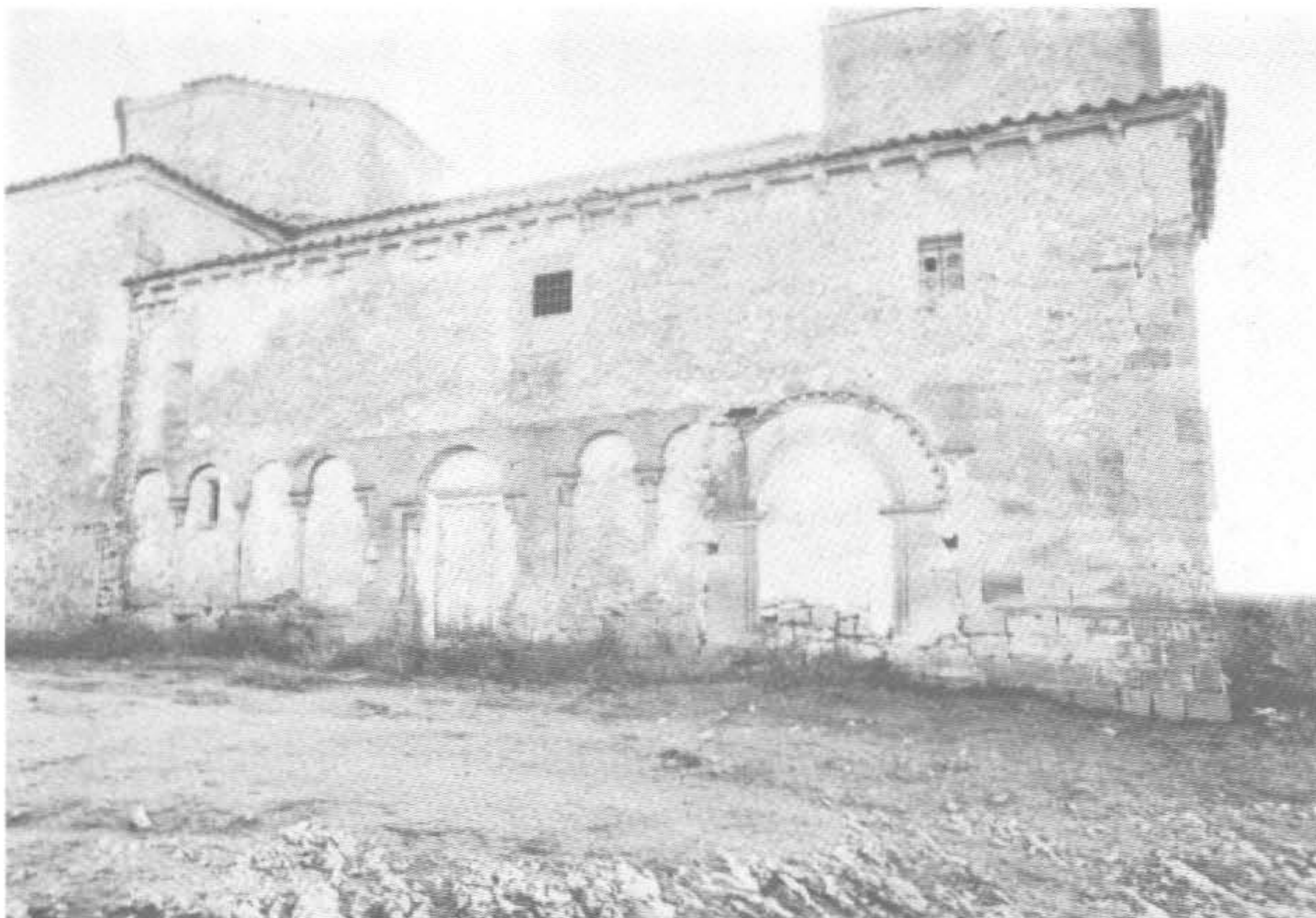
a) TORTONDA , vista de la cara norte de la iglesia parroquial, donde se observa la gran galería porticada, actualmente ya descubierta.
