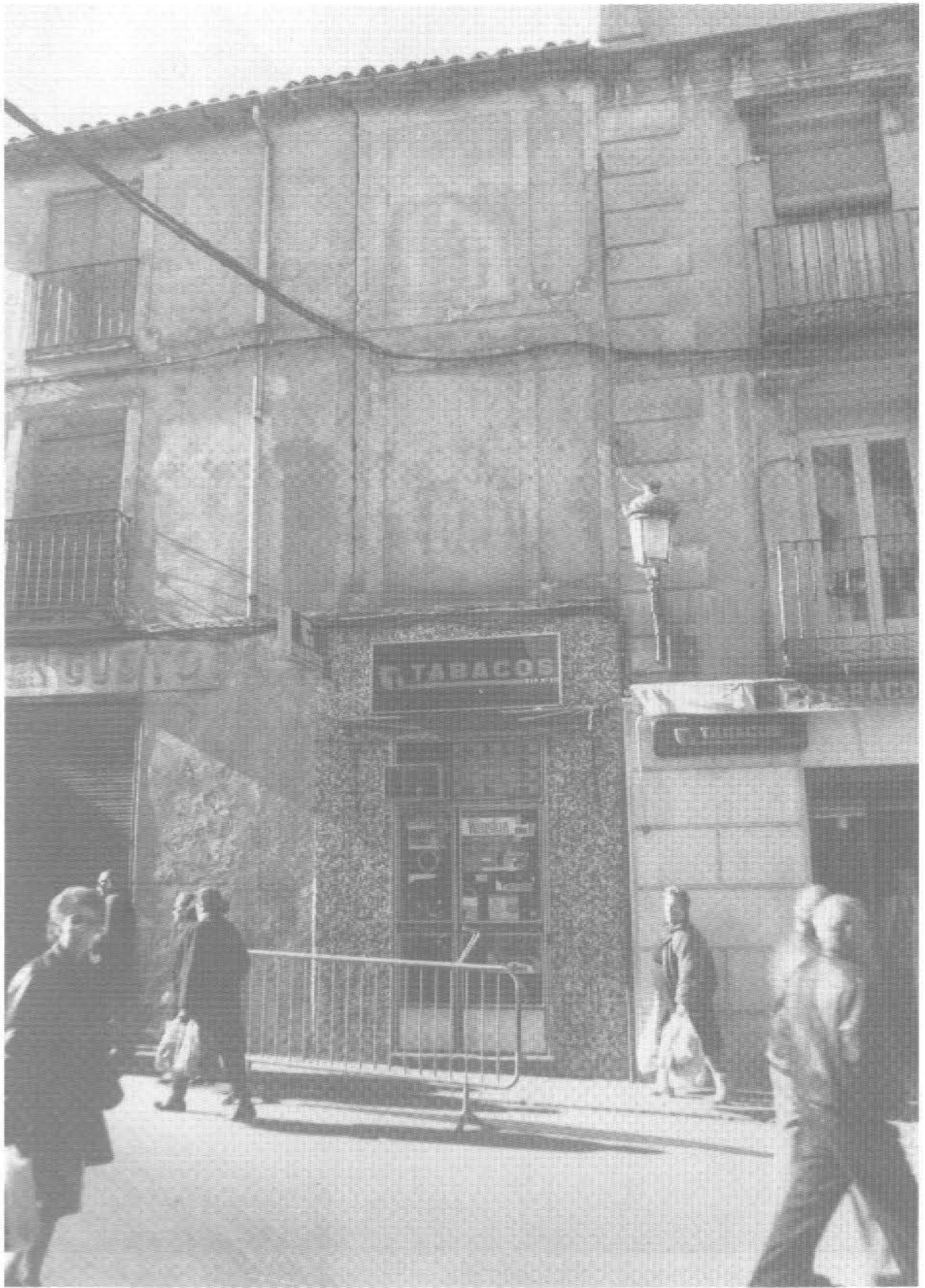
Callejuela del Carmen o Santo Domingo. El edificio que tapona su entrada desde la calle Mayor nos da muestras feacientes de su existencia al romperse la continuidad de su fachada en las plantas superiores.
