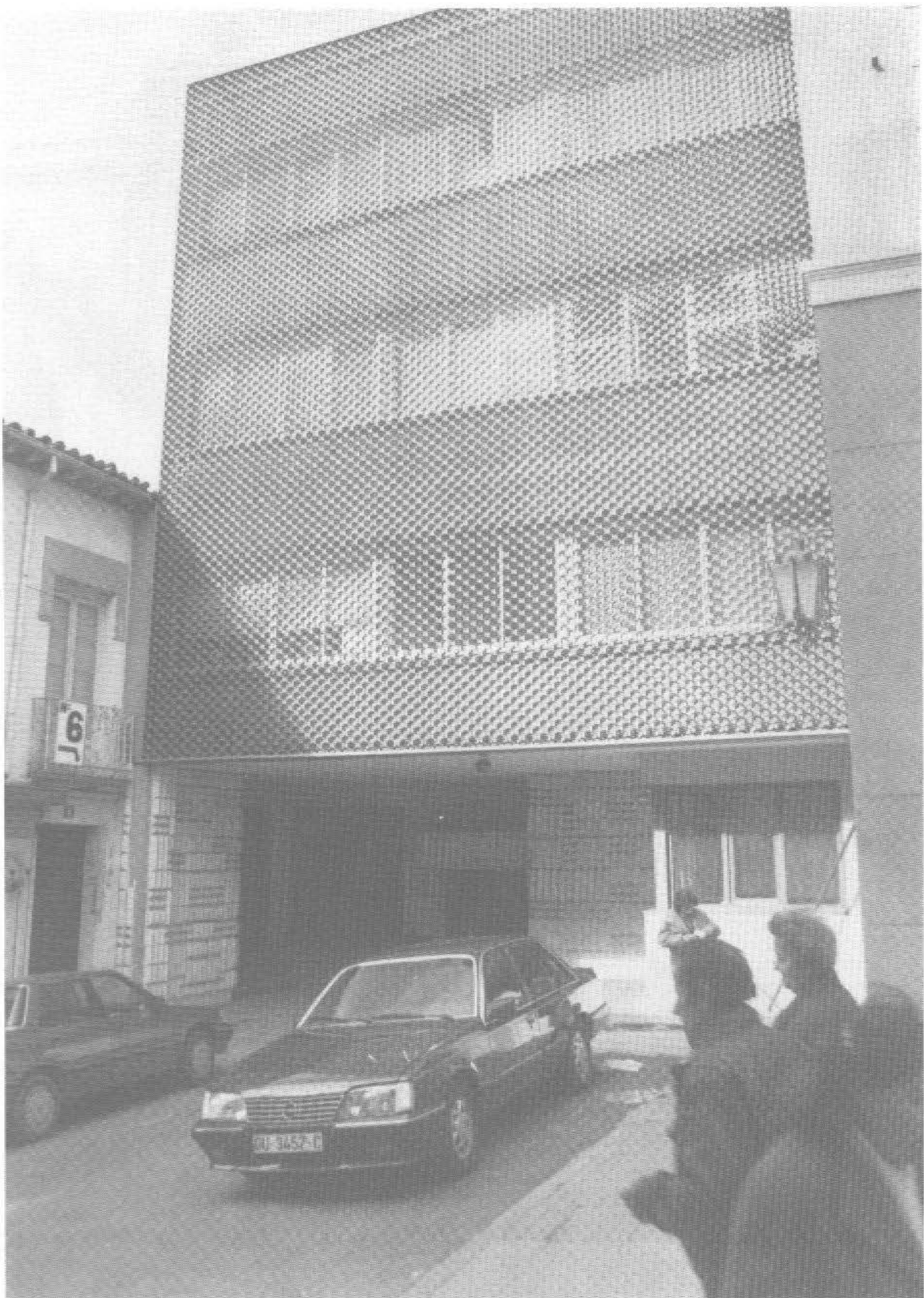
Callejuela de Carbonerías. Esta plazuela que da acceso al edificio administrativo del Ayuntamiento es el residuo urbano de aquella callejuela, sobre la que se ha levantado el nuevo edificio.
