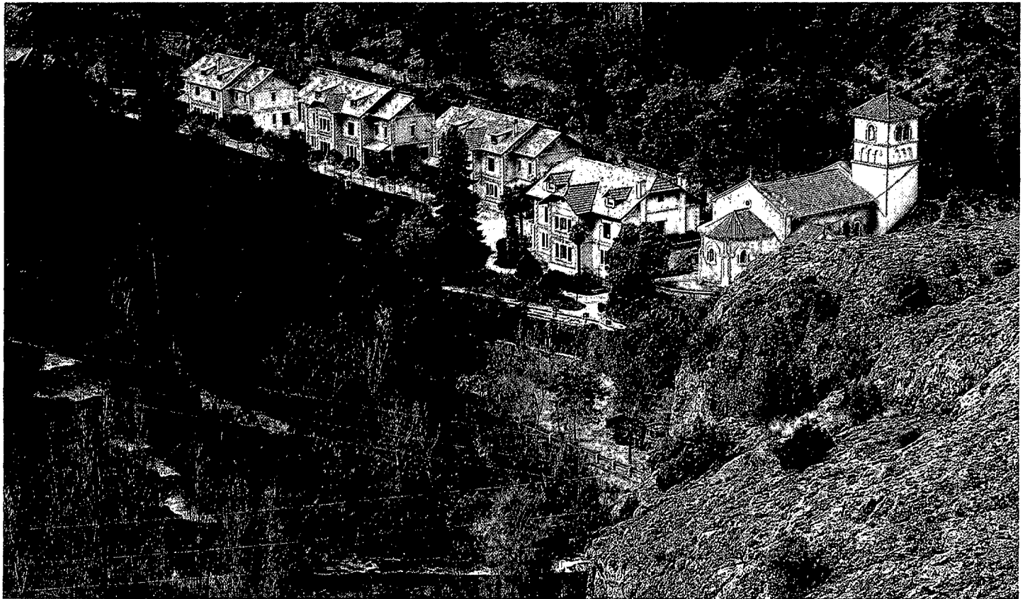
Central Hidroeléctrica de Villalba (Cuenca).
