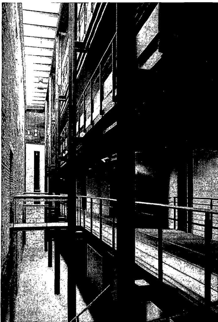
Recuperación del callejón interior, de San Pedro Mártir (Toledo).
