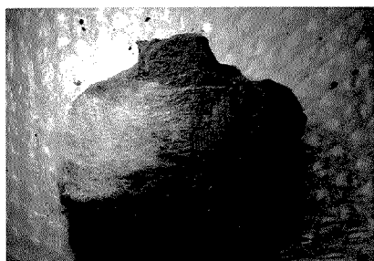
Refuerzo estructural del anverso.
