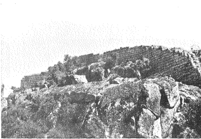
La Muralla sobre los canchos. Adviértase que no existen, en este lugar, cimientos. Puede verse el espesor del muro.
