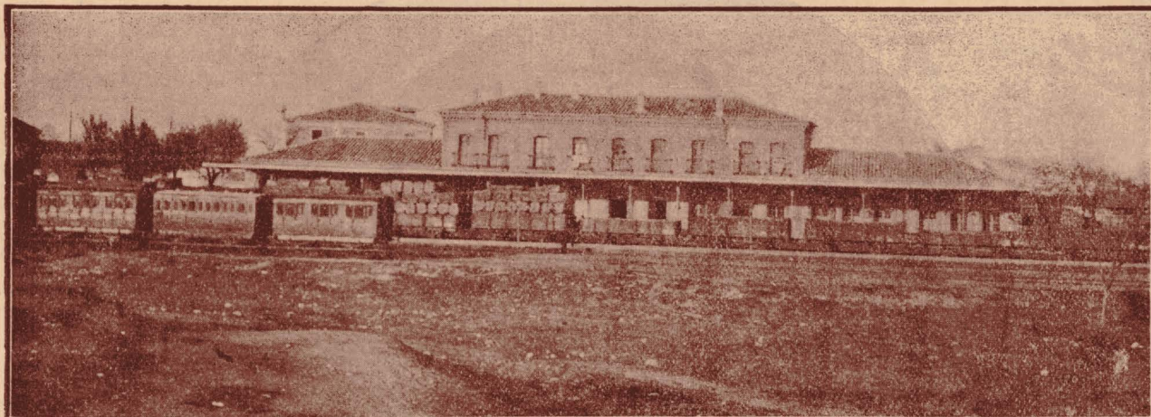
Vista de la Estación férrea de Ciudad-Real, donde recientemente se han introducido grandes reformas, entre ellas el alumbrado por fluido eléctrico y nuevos pabellones para la mejor instalación de los servicios.
