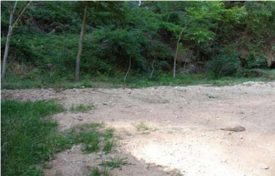
Fig. 8. Daños provocados por la maquinaria en las obras de ensanche de la pista forestal de La Molata
