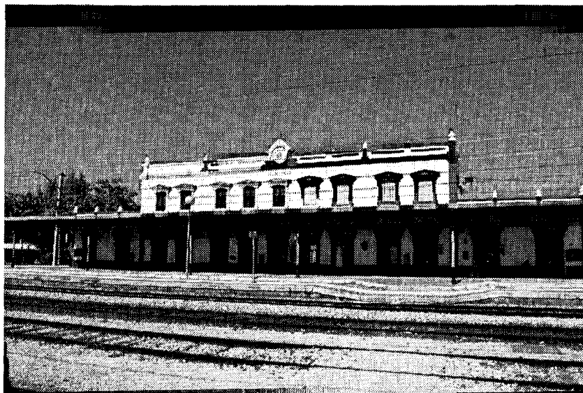
Imagen 8.- La estación de Valdepeñas. Fotografía del autor.
