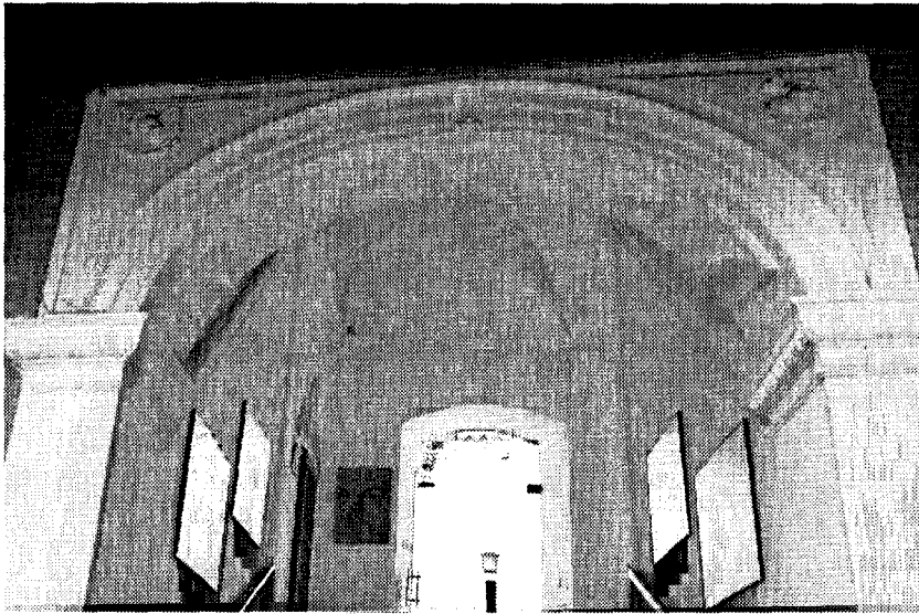
Fig. 4. Detalle de la escalera del Almacén de los Fúcares.
