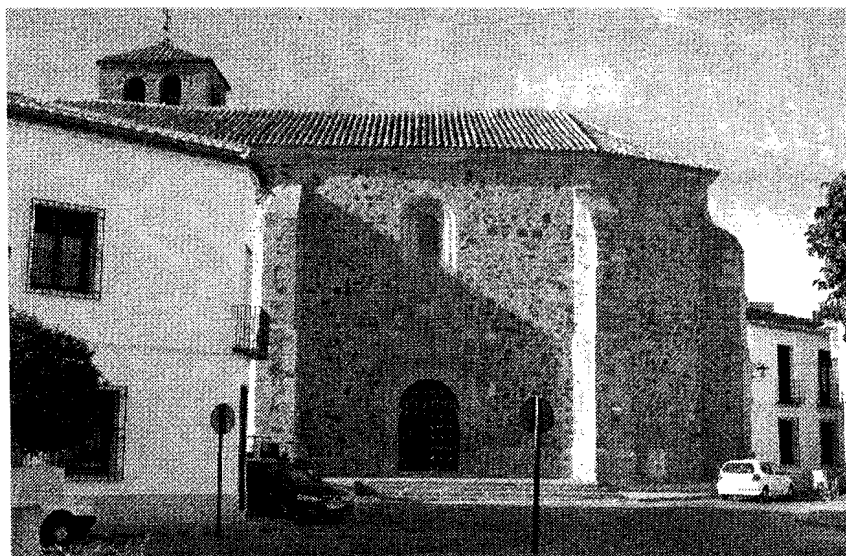
Fig. 5. Fachada meridional de la Ermita de San Salvador (San Blas).
