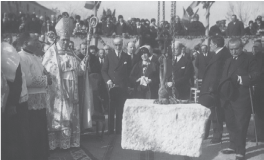
Colocación de la primera piedra de la Normal de la Vega. 1929.
